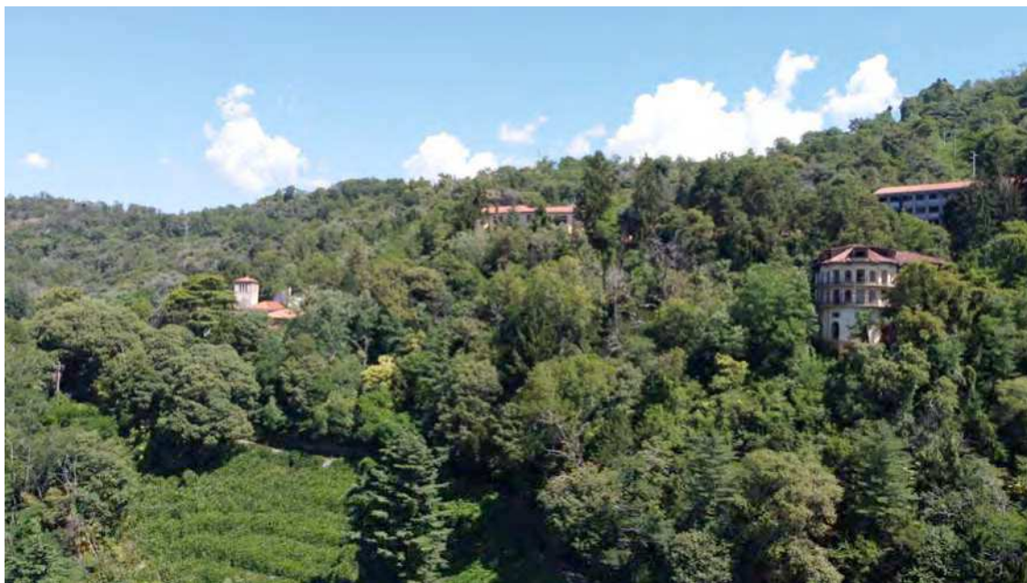
Figura 2-15: foto d'insieme (con drone) – l'immagine consente di percepire il tipo di vegetazione esistente e l'efficacia mitigativa anche per gli edifici più imponenti.
