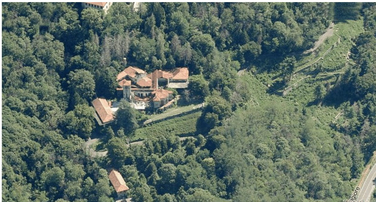
Foto aerea edifici 2 e 3 – edificio 3 al centro
