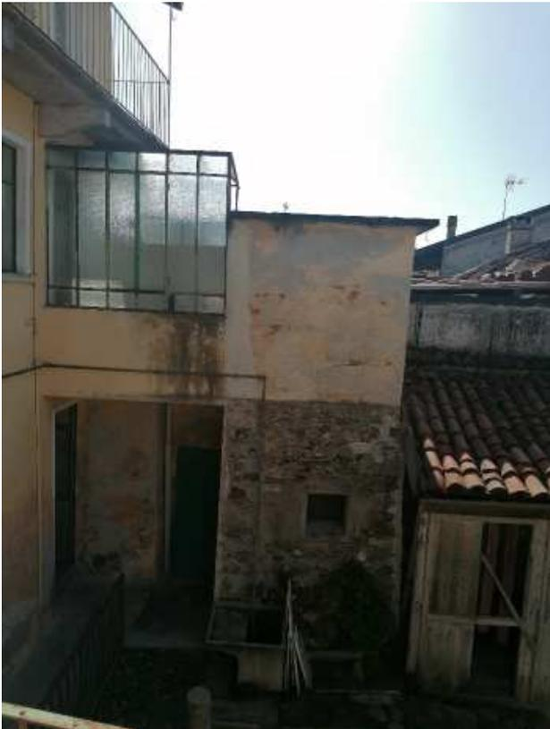
Foto 44-45-46: Umidita' -distacchi di intonaci e crepe diffuse;
