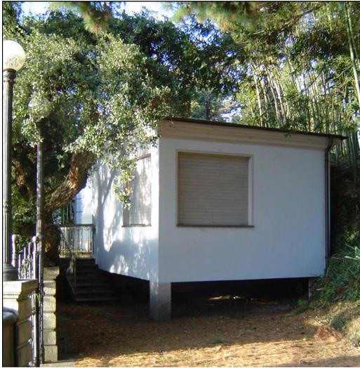
**Figura 19.** Immagine d'archivio del fabbricato addossato alla darsena dalla quale si evince che la struttura dell'edificio è appoggiata su pilastri angolari e che un tempo la parte inferiore al di sotto del solaio di calpestio era aperta, a somiglianza di una palafitta.
