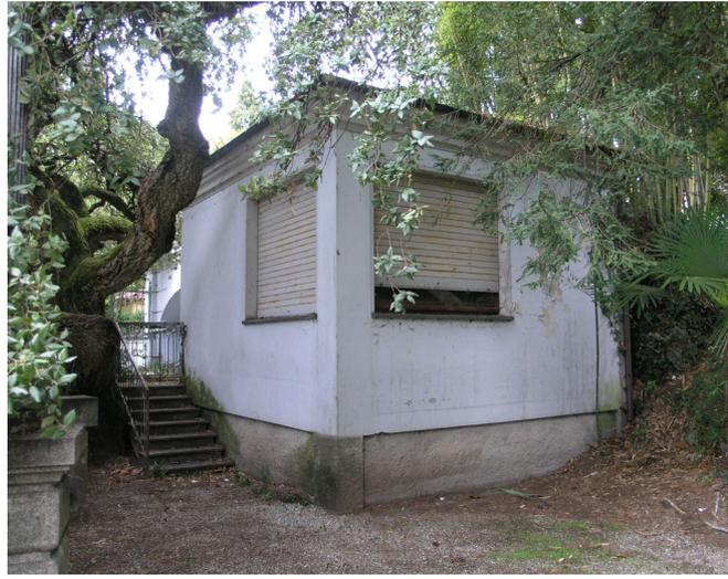
**Figura 20.** Stato attuale del fabbricato addossato alla darsena: sono ancora evidenti i pilastri angolari ma la parte inferiore al di sotto del solaio di calpestio risulta tamponata.
