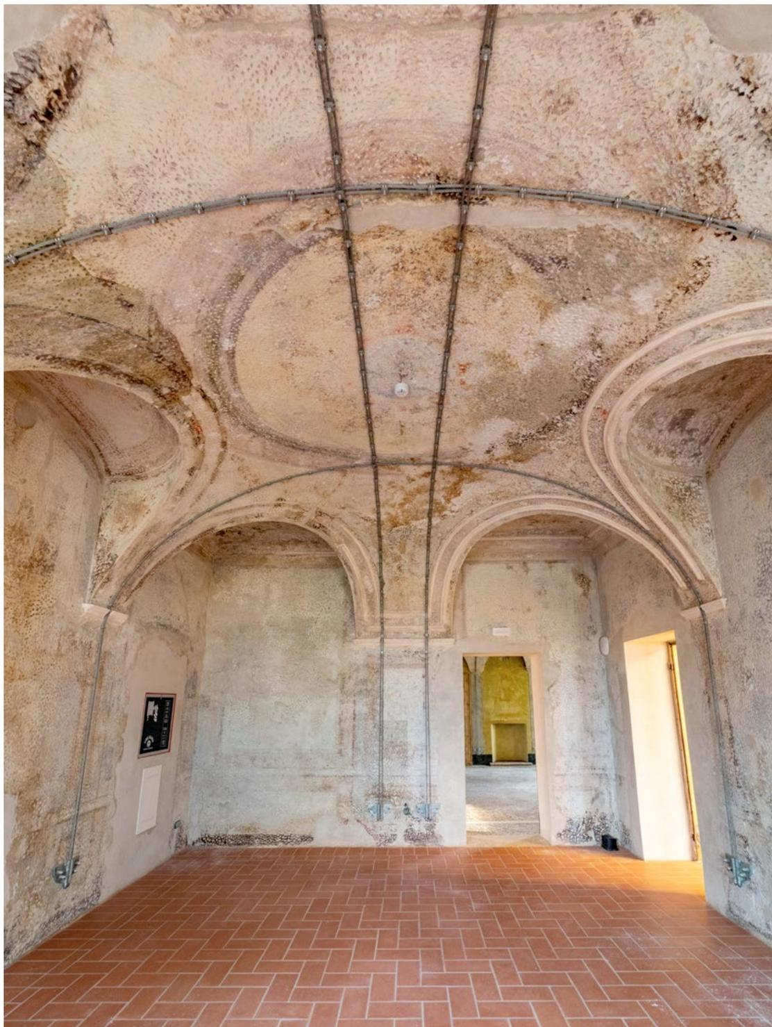
Fig. 1. La sala cosiddetta «picchettata» al piano primo dopo i restauri e il consolidamento con il sistema dell'arco armato intradossale
