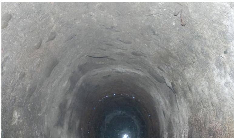
Fig. 11. L'invaso del pozzo US 1 in ciottoli fluviali legati da malta nella parte superiore e laterizi in quella inferiore
