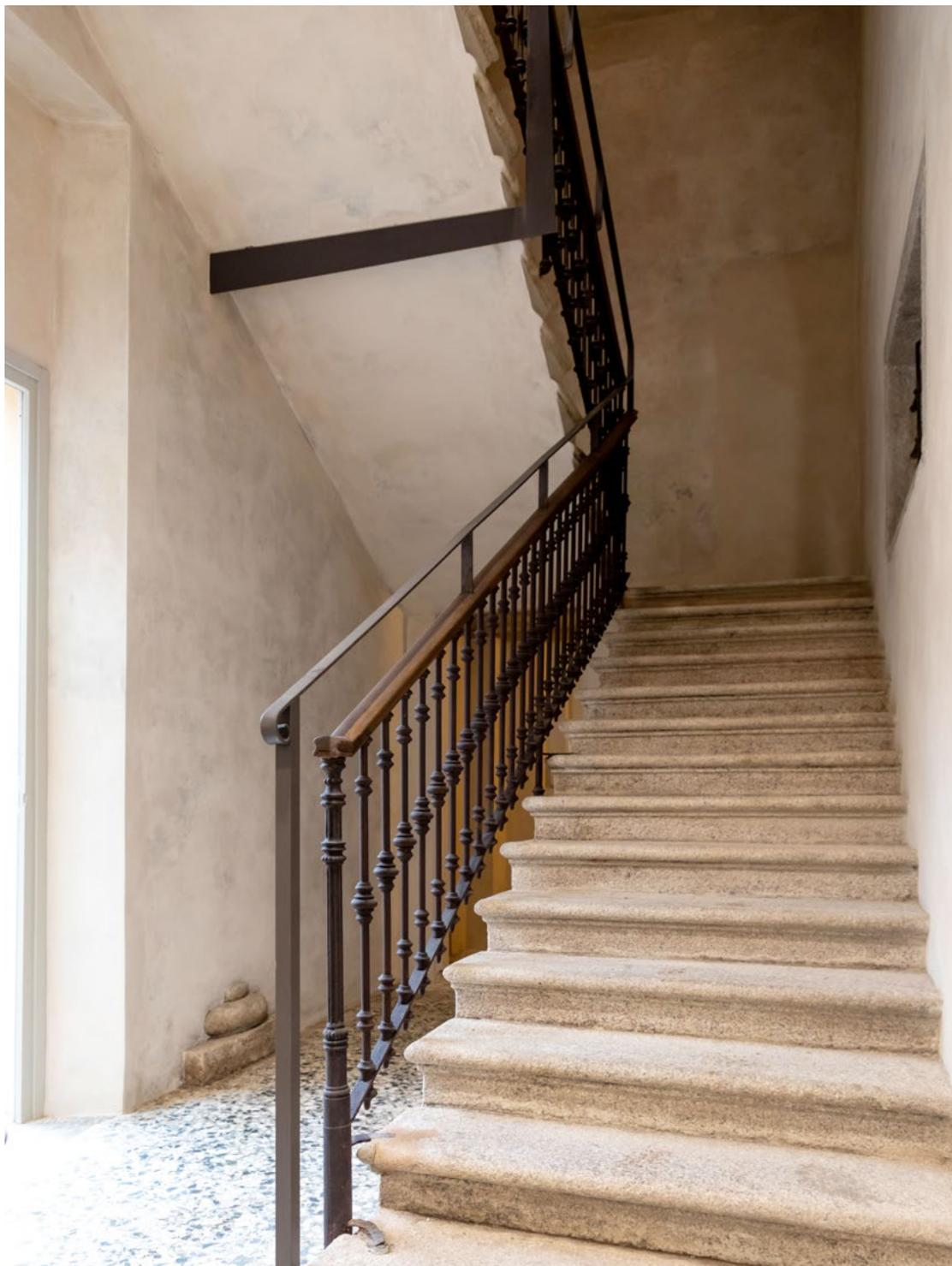
Fig. 4. Il consolidamento e restauro della scala e del parapetto in ferro battuto con corrimano di legno
