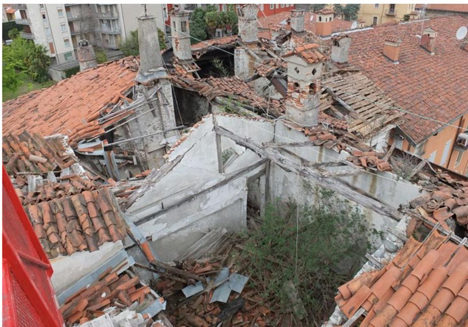
Fig. 2. Le coperture di Villa Simonetta devastate dai crolli, come si presentavano ad inizio cantiere nel 2018
