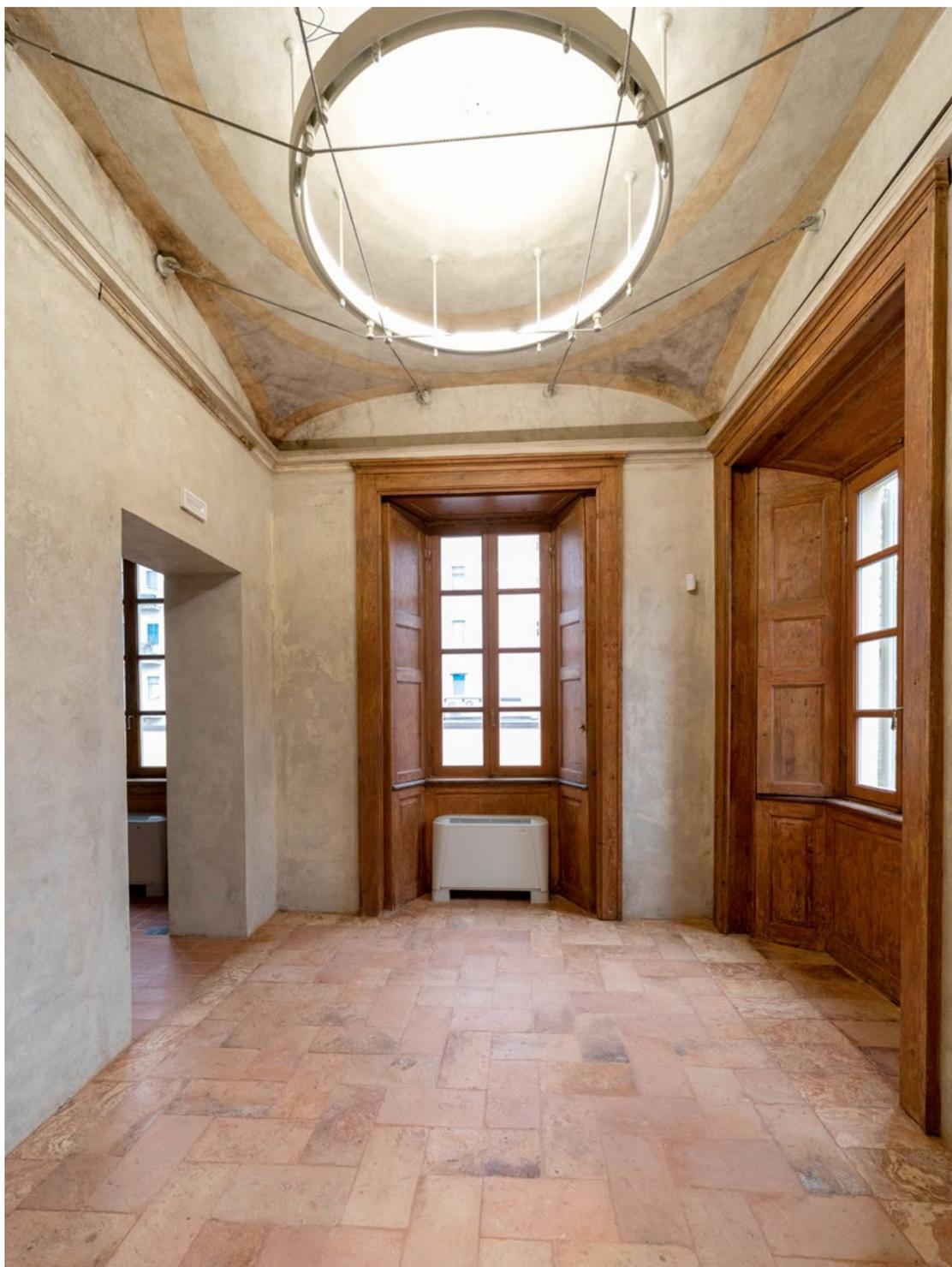
Fig. 3. Il consolidamento della saletta del piano primo con il sistema del cosiddetto «lampadario strutturale»
