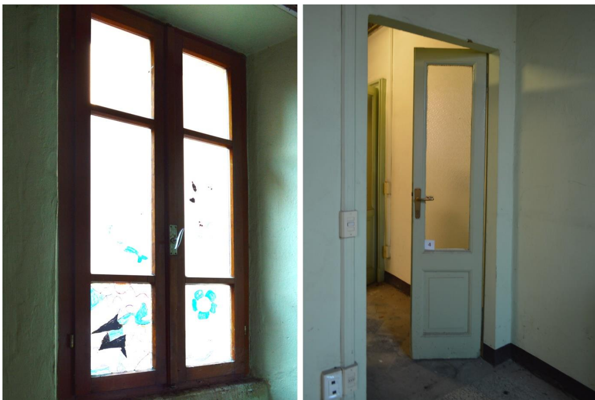
F101. Stato di fatto, locale P3.04 – Particolare delle porte in legno esistenti e dei serramenti
