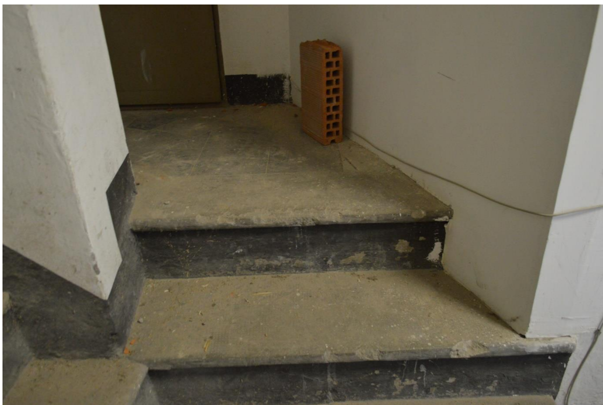
F95. Stato di fatto, locale P3.02 – Gradini di accesso ai locali tecnici
