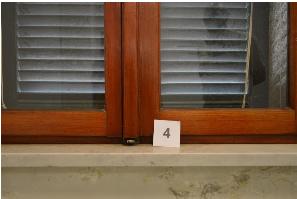
F53. Stato di fatto, locali P1.05, P1.07 e P1.09 – Davanzali interni in marmo
