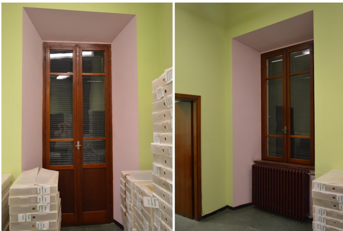
F44. Stato di fatto, locale P1.01 – Serramenti interni
