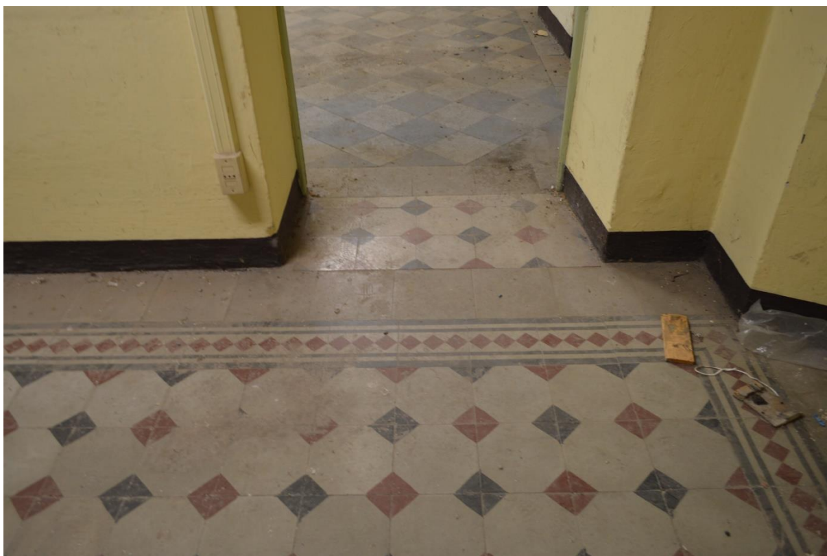
F87. Stato di fatto, locale P3.01 – Particolare della pavimentazione in cementine (tipo 1)
