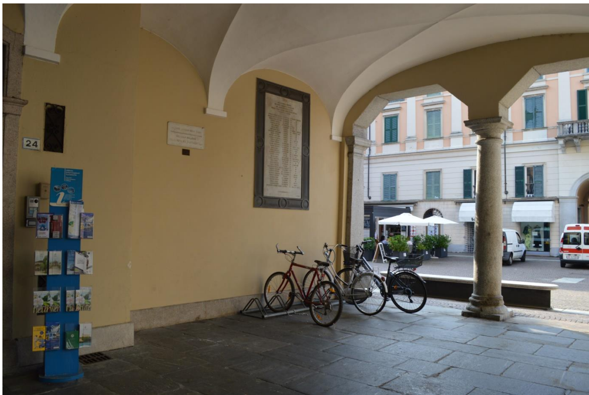
F23. Fronte ovest, piano terra: portico con colonne circolari e colonne perimetrali squadrate e archi semi-ottagonali in granito; pavimentazione originaria in lastre di beola grigia e soffitto con volte a crociera
