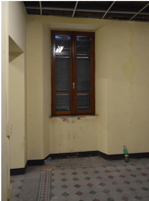
F84. Stato di fatto, locale P3.01 – Stanza con pavimentazione in cementine (storiche)
