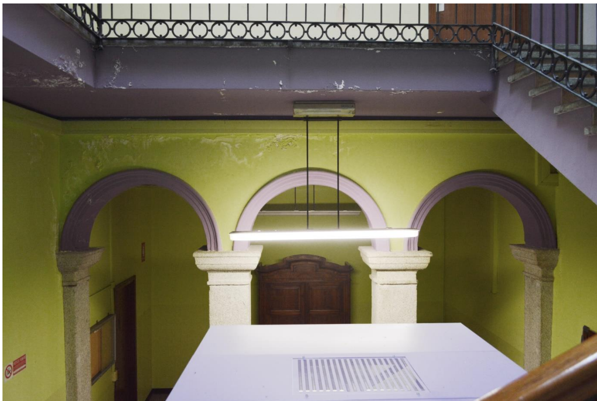
F61. Stato di fatto, locali P1.06 e P1.08 – Vista dalla scala che conduce al secondo piano
