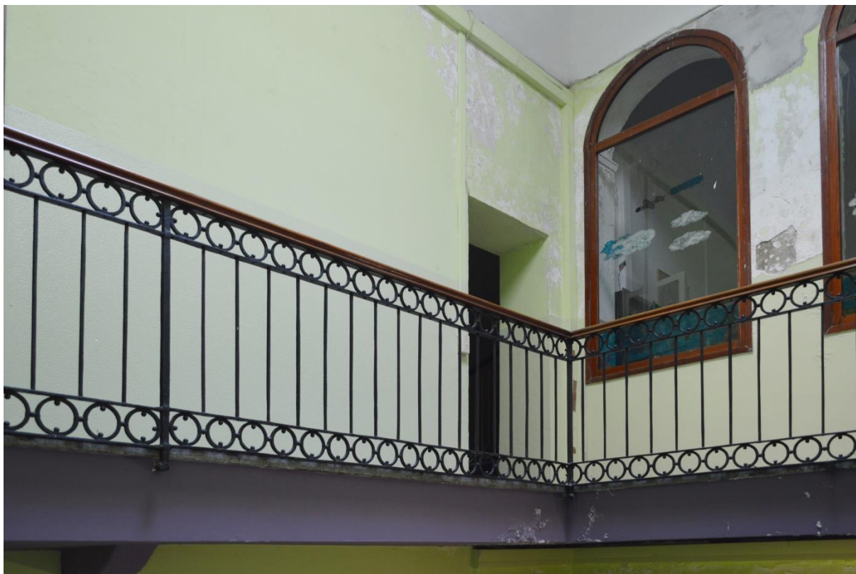
F76. Stato di fatto, locale P2.08
