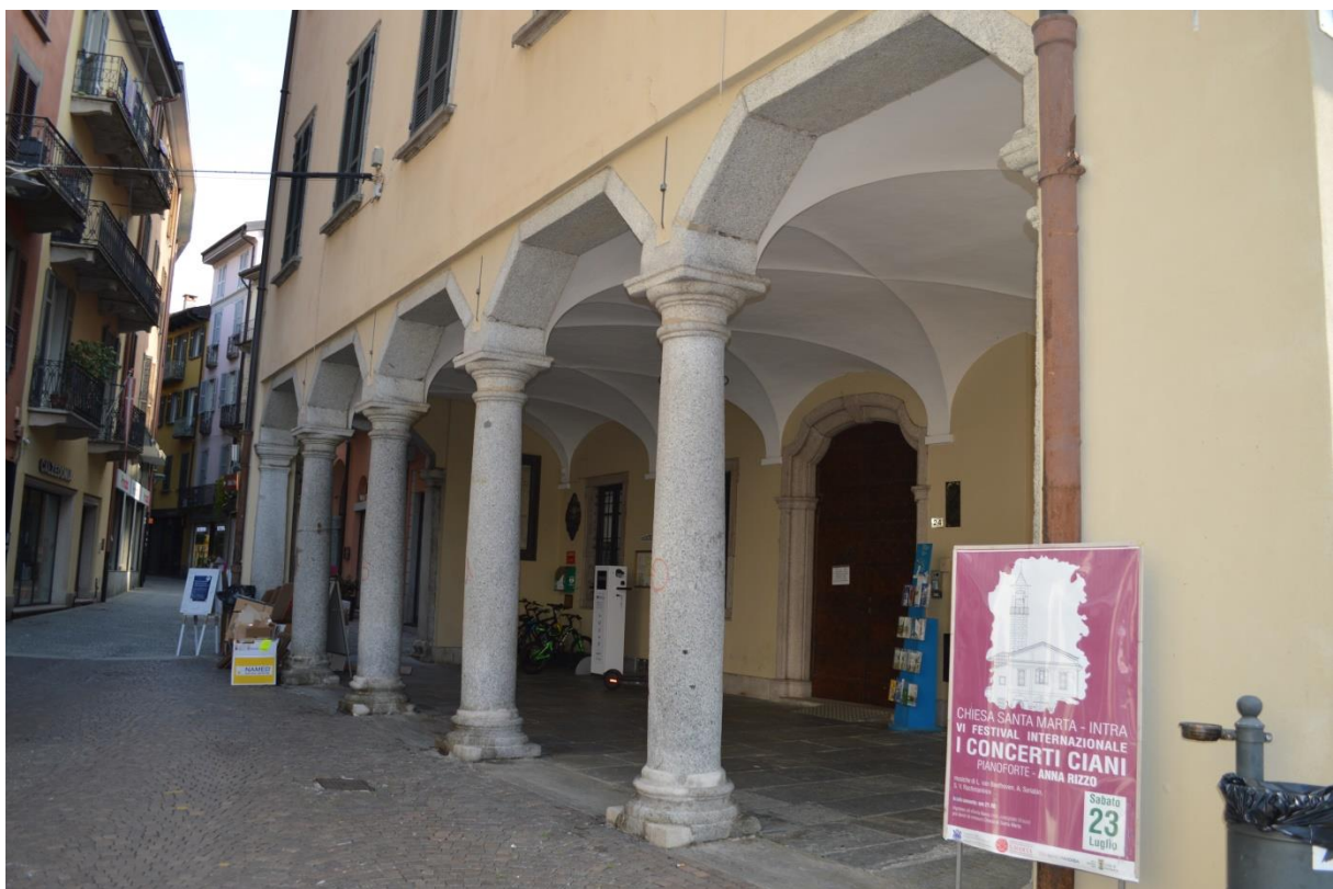
F13. Fronte ovest, piano terra: portico con colonne circolari e colonne perimetrali squadrate e archi semi-ottagonali in granito; pavimentazione originaria in lastre di beola grigia e soffitto con volte a crociera
