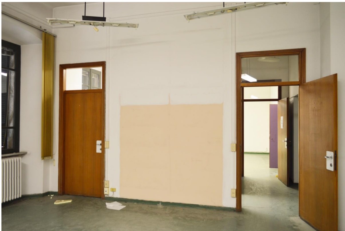
F74. Stato di fatto, locale P2.12
