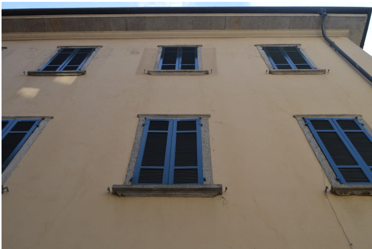
F15. Fronte ovest, piano primo e secondo – finestre con davanzali e contorni in granito e gronda in pietra con fascia sotto-gronda in rilievo
