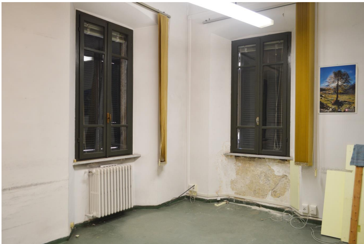
F70. Stato di fatto, locale P2.07
