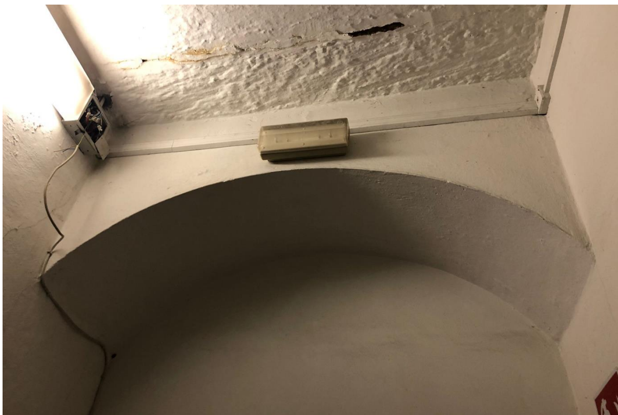
F69. Stato di fatto, locale P2.03 – Disimpegno – Arco attualmente tamponato
