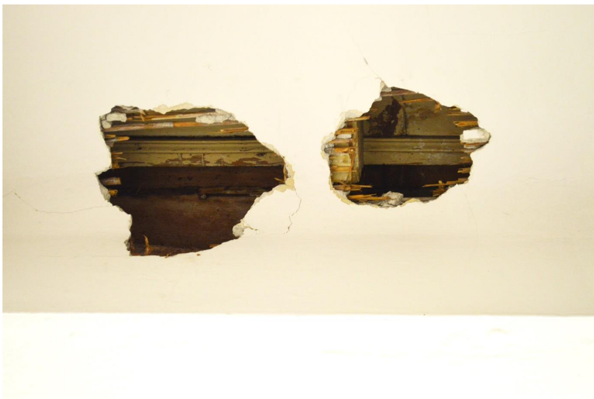
F75. Stato di fatto, locale P2.07 - Prova per verifica solai esistenti
