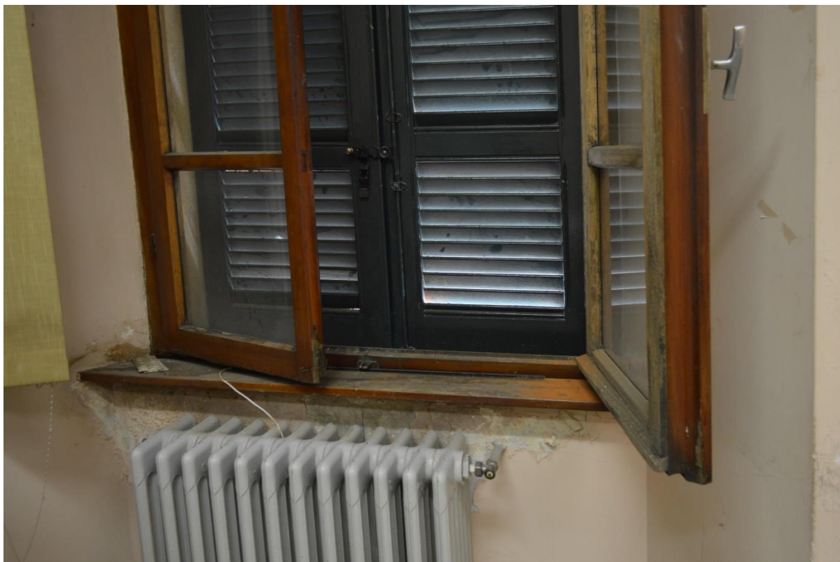
F63. Stato di fatto, locale P2.02 – Serramenti interni e davanzale interni in legno
