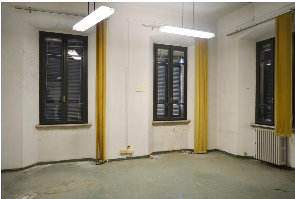
F73. Stato di fatto, locale P2.012
