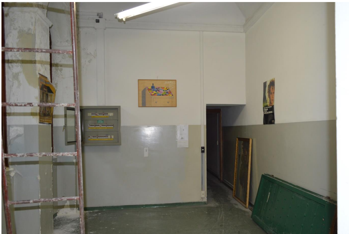
F82. Stato di fatto, locale P2.10
