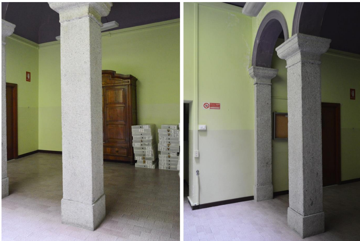
F56. Stato di fatto, locali P1.06 e P1.08 – Particolare delle colonne esistenti
