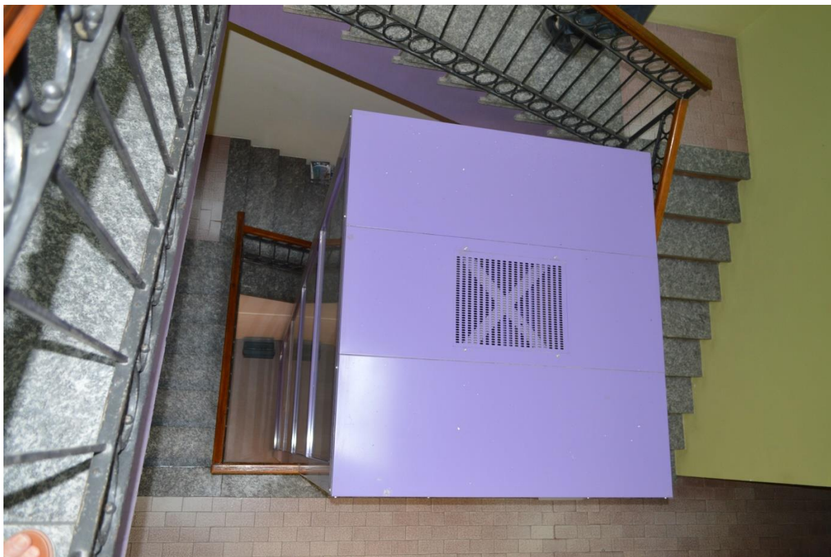
F78. Stato di fatto, locale P2.08 – vista dal ballatoio dei piani sottostanti
