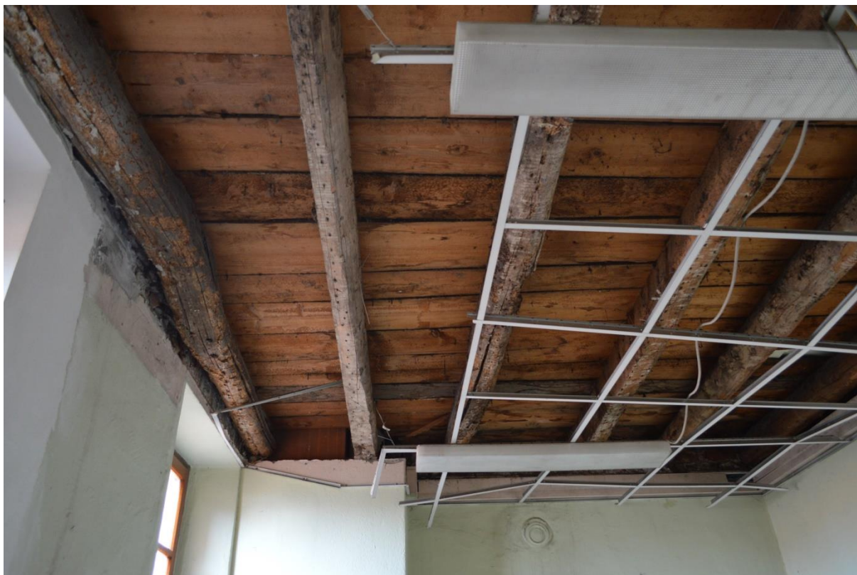
F100. Stato di fatto, locale P3.04 – Solaio in legno e struttura di controsoffitto recente
