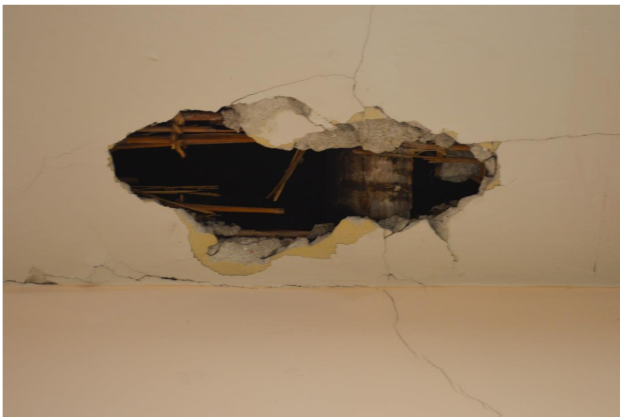
F65. Stato di fatto, locale P2.05 – Prova per verifica solai esistenti
