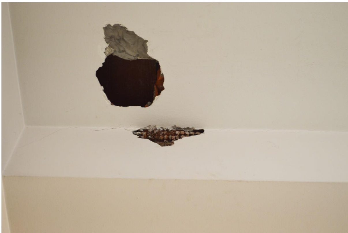
F51. Stato di fatto, locale P1.8 – Prove su soffitto con finitura intonacata su cannicciato
