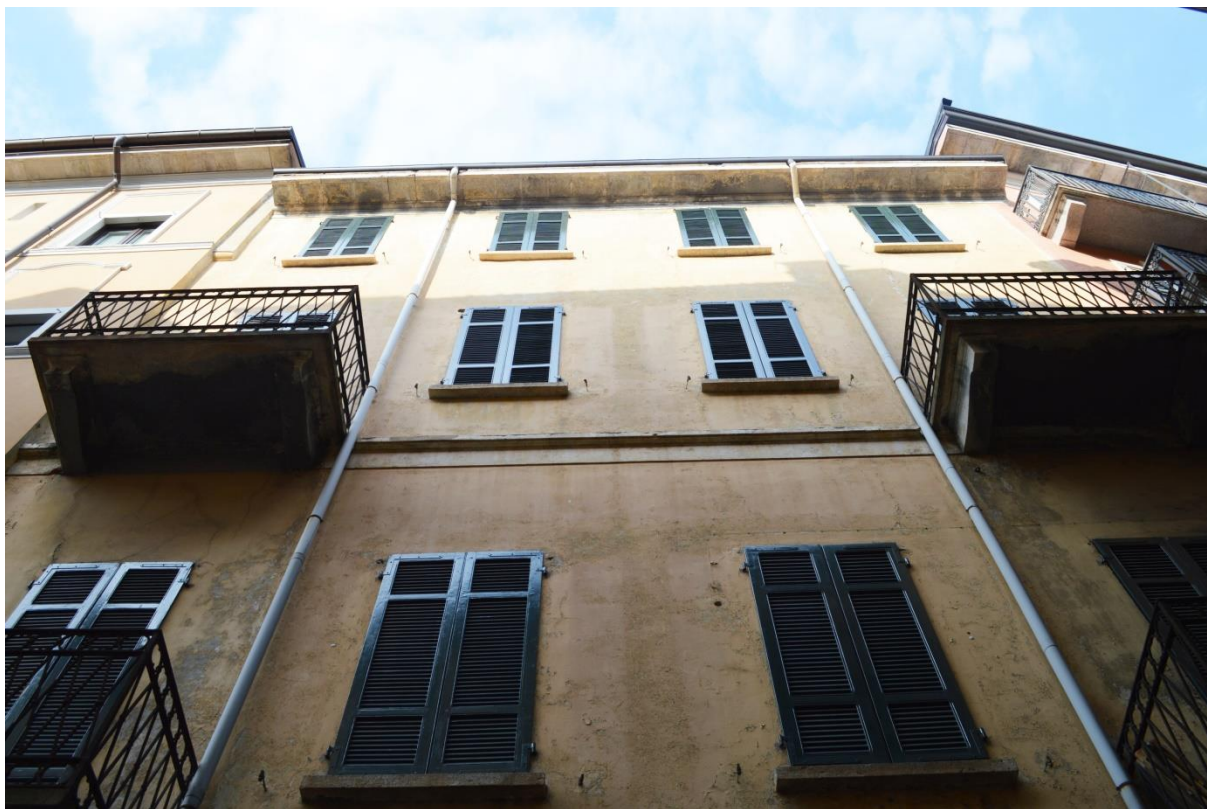
F02. Via San Vittore, piano primo, secondo e terzo – fasce marcapiano e fascia sotto-gronda in rilievo
