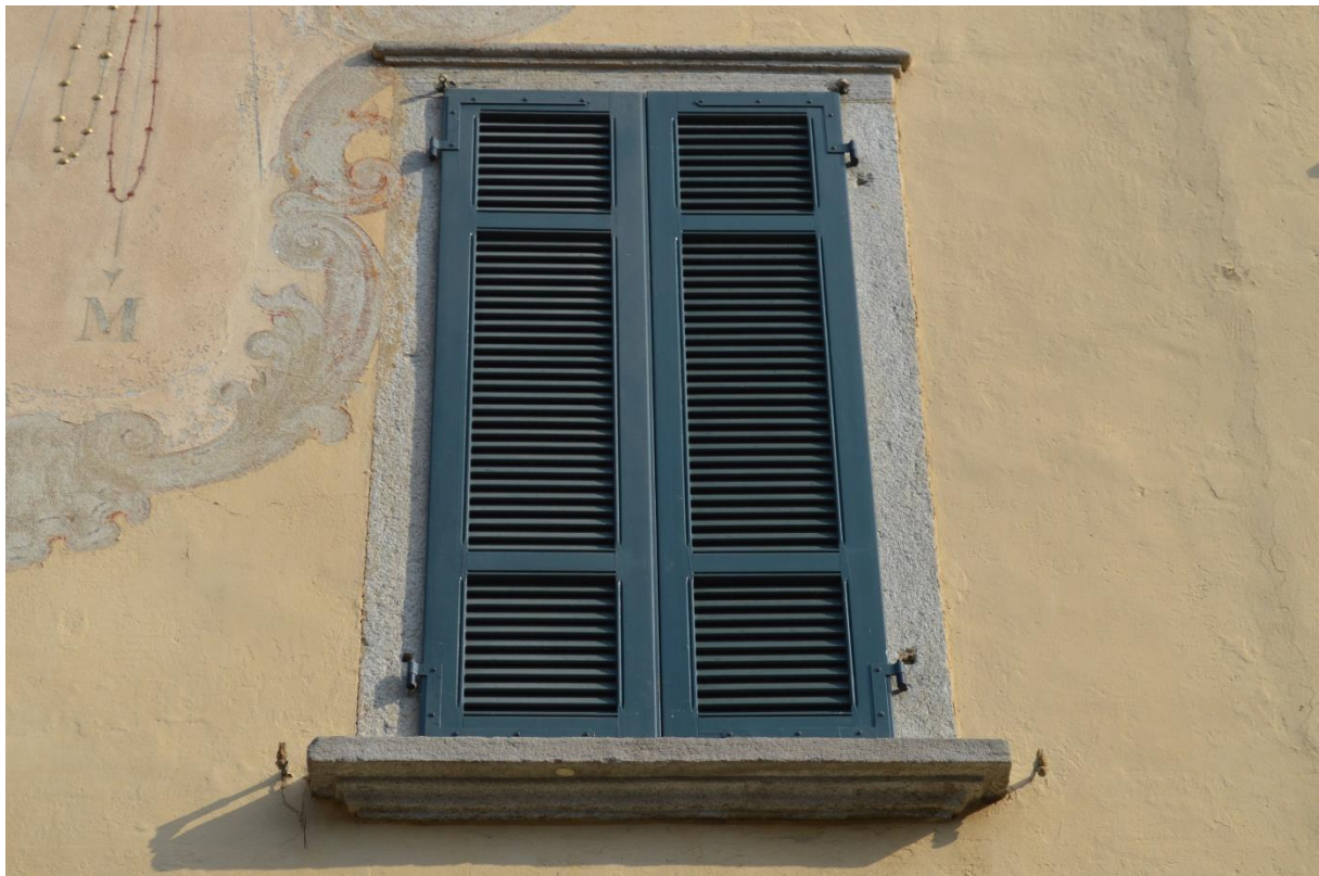
F12. Fronte sud, piano primo: particolare finestra con davanzali e cornici in granito e con gelosie in legno
