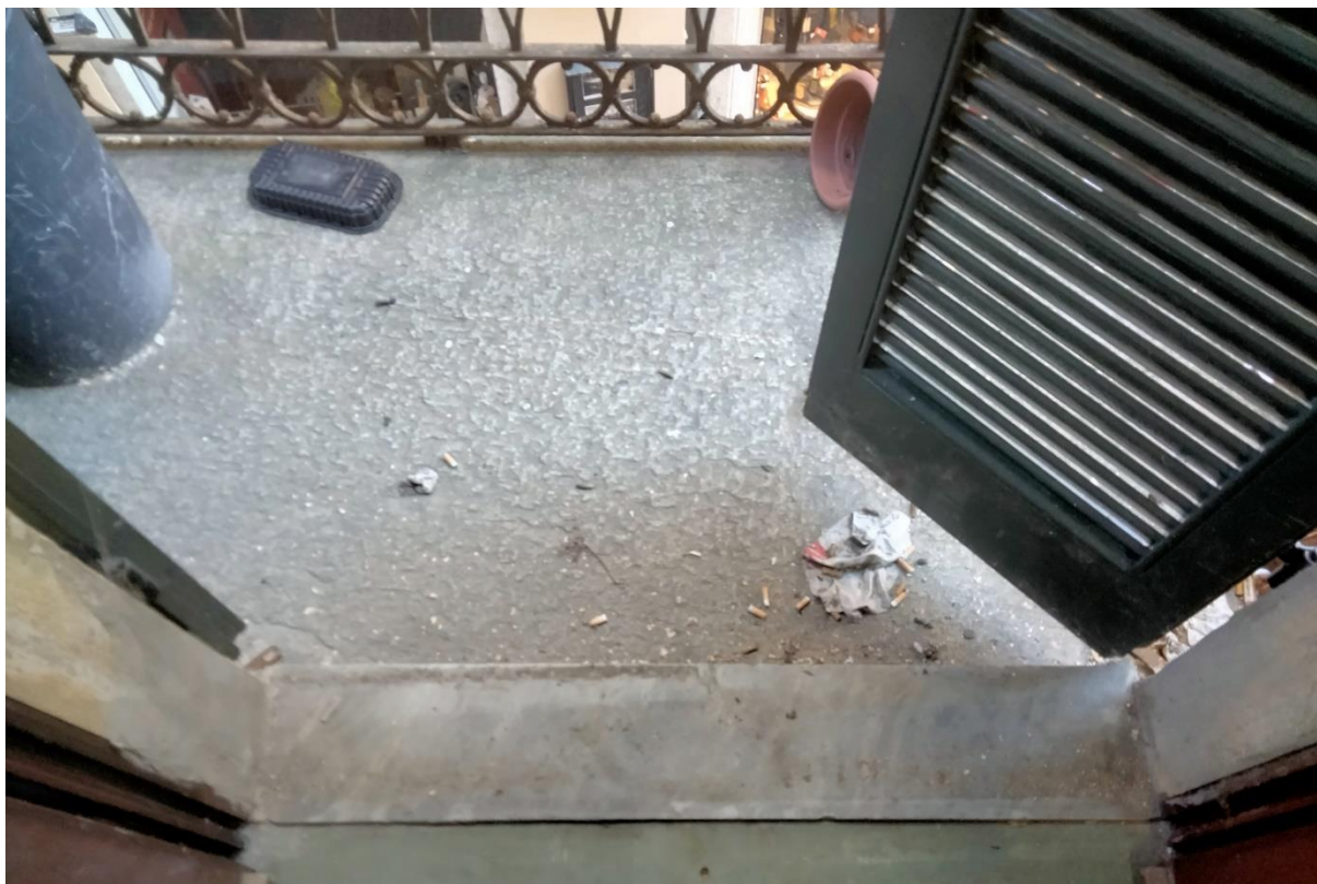
F45. Stato di fatto, locale P1.03 – Soglia in marmo verso il balcone esterno in beola grigia bocciardata
