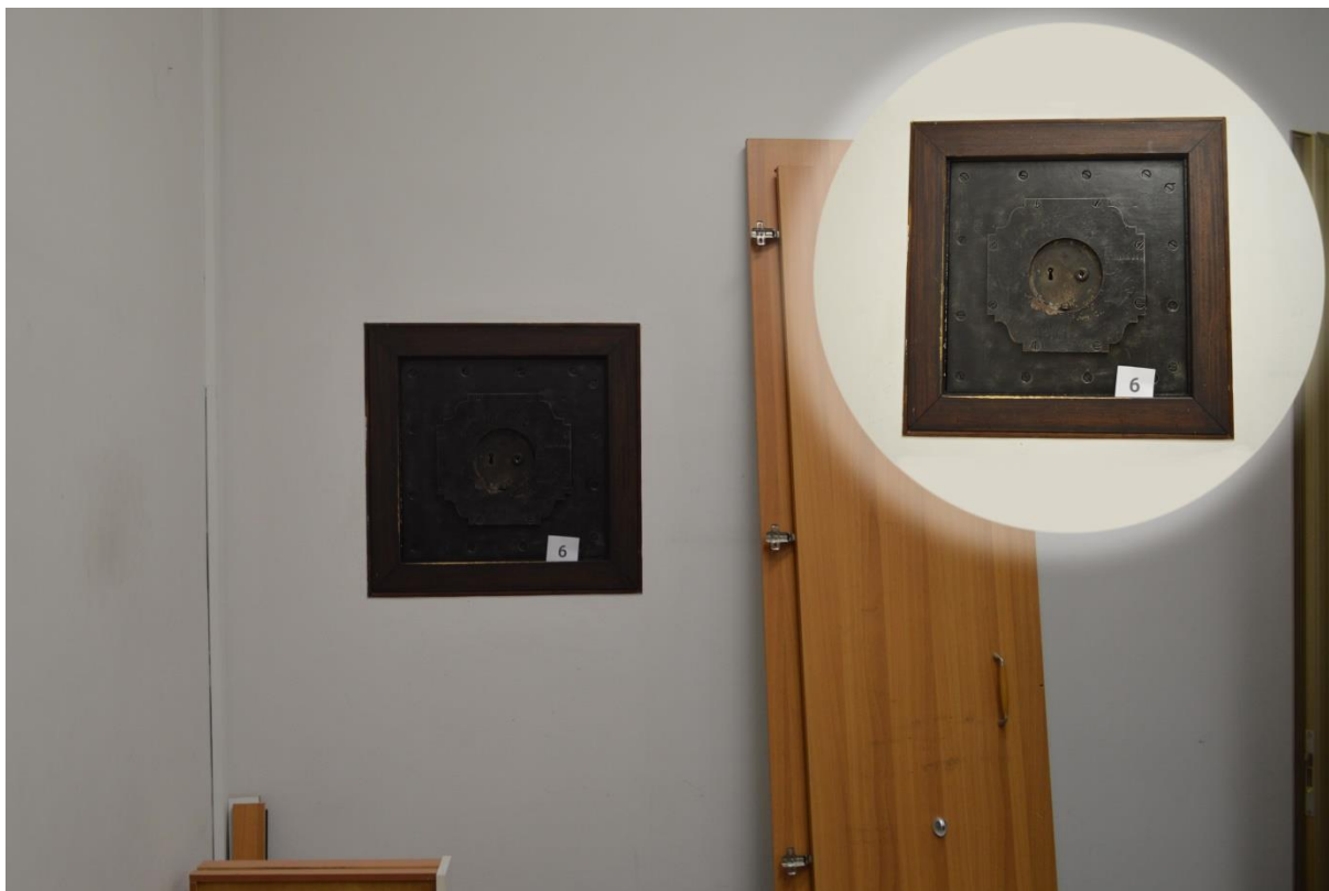
F55. Stato di fatto, locale P1.05 – Particolare della cassaforte a muro esistente
