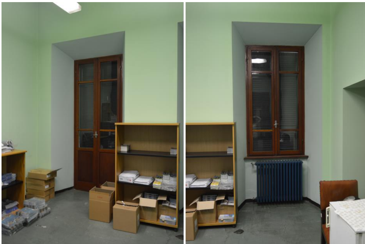
F41. Stato di fatto, locale P1.03 – Serramenti interni
