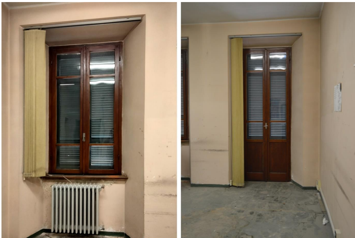
F62. Stato di fatto, locali P2.02 e P2.05 – Serramenti interni
