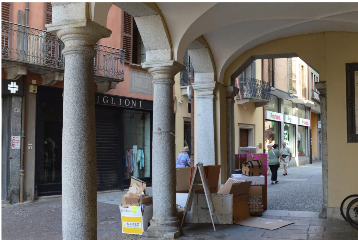
F20. Fronte ovest, piano terra: portico con colonne circolari e colonne perimetrali squadrate e archi semi-ottagonali in granito; pavimentazione originaria in lastre di beola grigia e soffitto con volte a crociera
