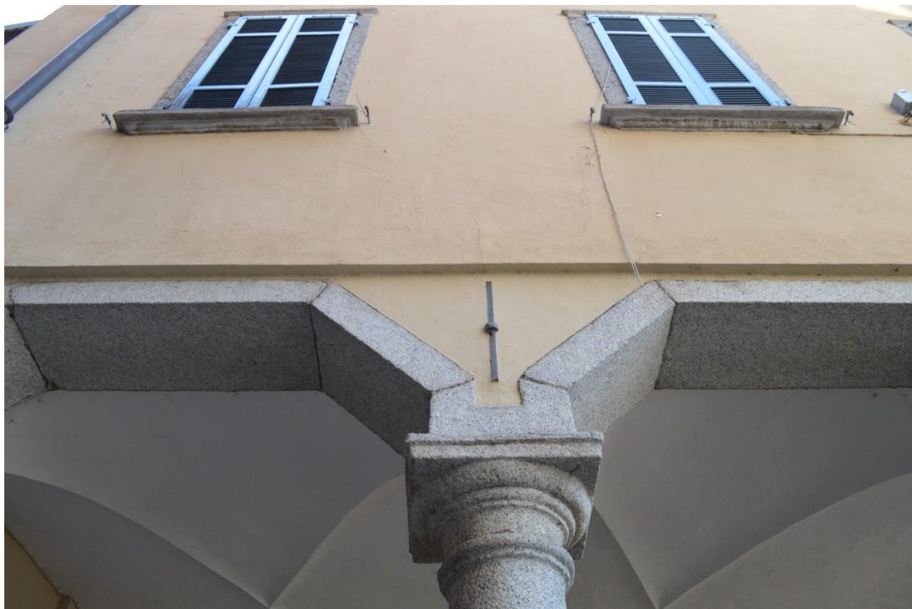
F14. Fronte ovest, piano terra: particolare del portico dove affiorano dalla muratura le catene in ferro
