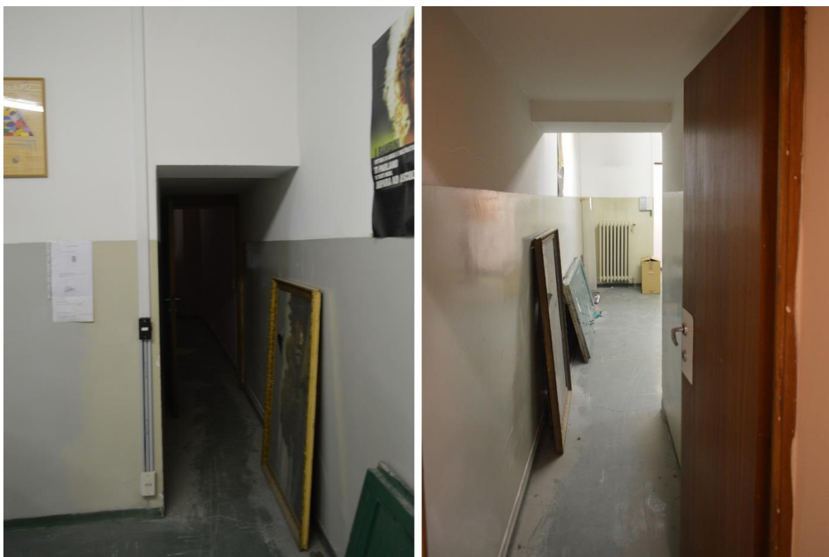
F83. Stato di fatto, locale P2.01 – Disimpegno e passaggio a quota H200 cm
