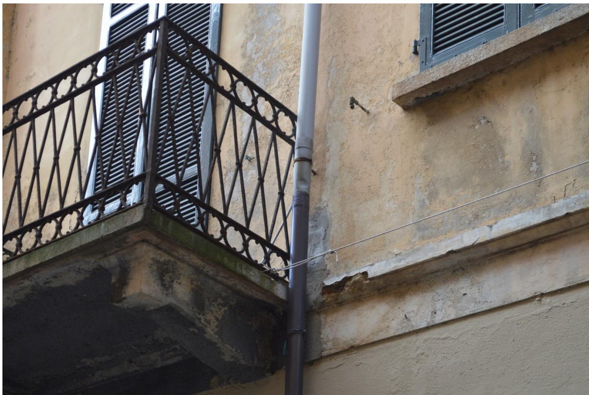
F04. Via San Vittore, piano primo: particolare della fascia marcapiano tra PT e P1
