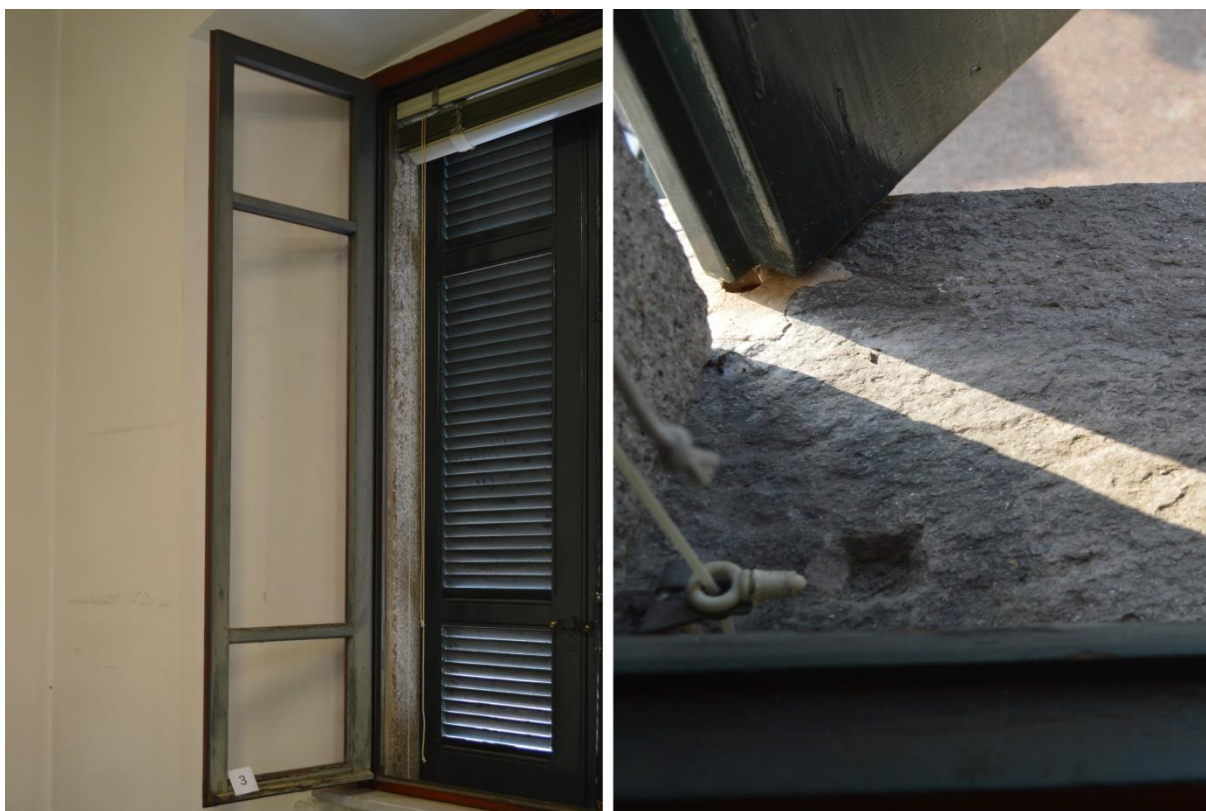
F54. Stato di fatto, locali P1.05, P1.07 e P1.09 – Davanzali interni in marmo ed esterni in pietra
