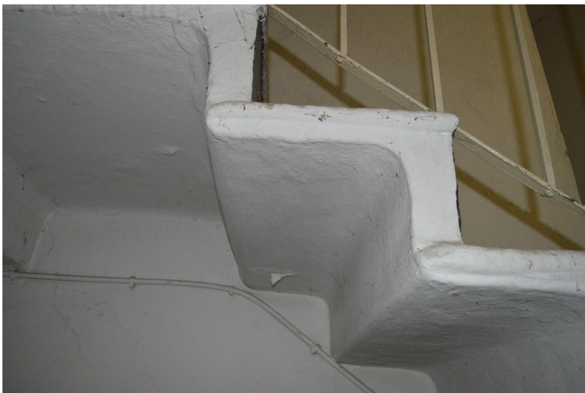
F89. Stato di fatto, locale P3.02 – Particolare della scala in beola grigia e beola scura che prosegue verso il sottotetto
