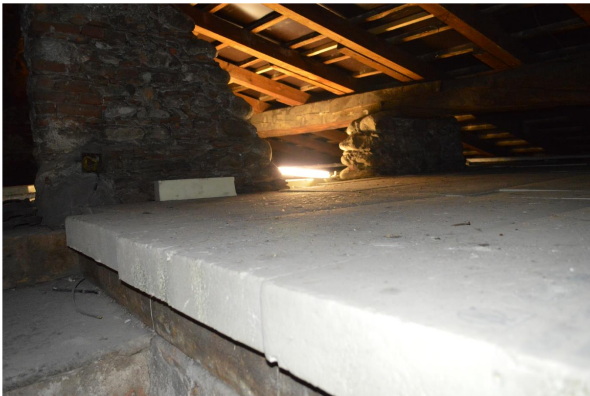
F105. Stato di fatto, sottotetto – particolare dell'isolante attualmente esistente
