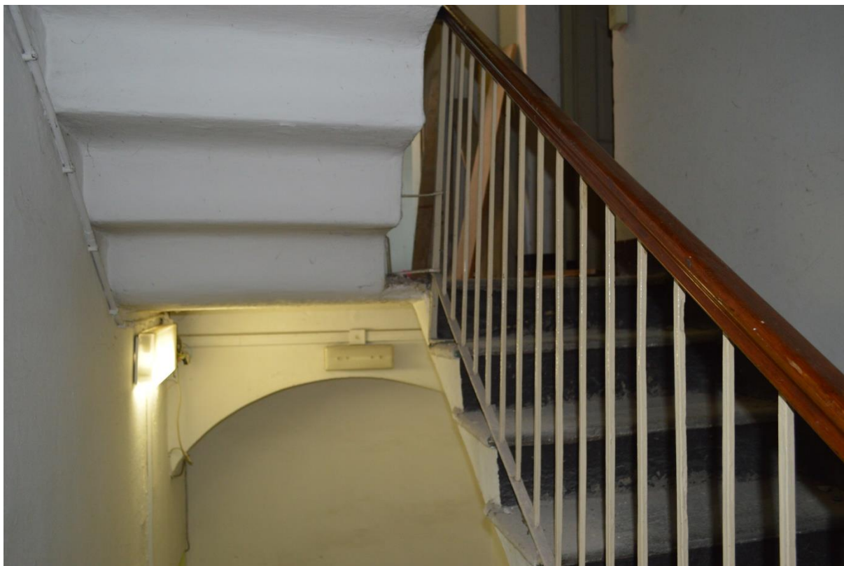
F92. Stato di fatto, locale P3.02 – Scala che prosegue verso il sottotetto
