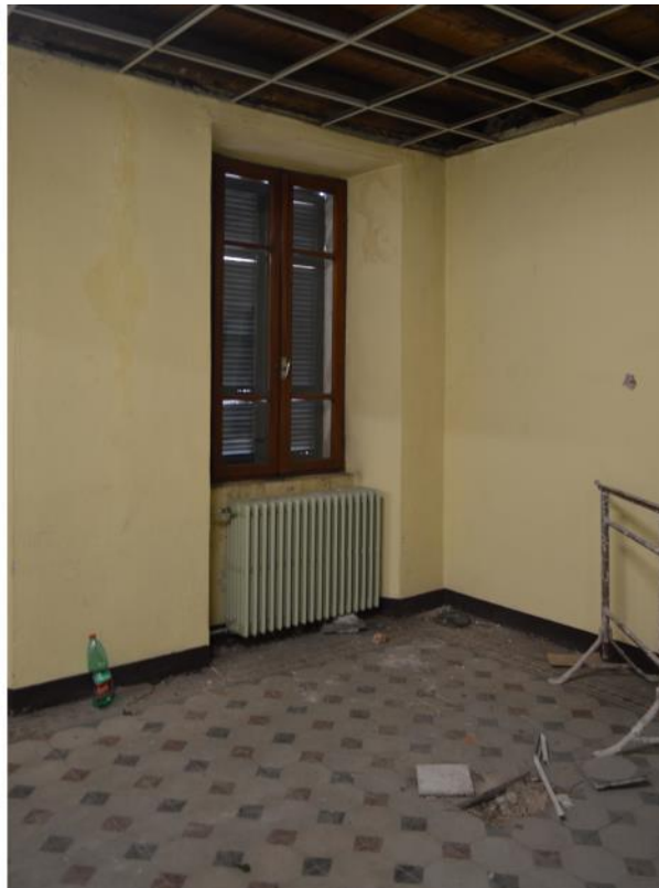
F84. Stato di fatto, locale P3.01 – Stanza con pavimentazione in cementine (storiche)
