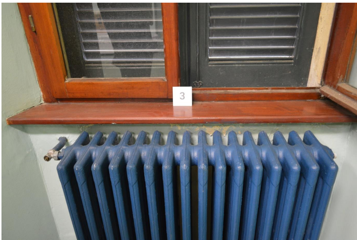
F46. Stato di fatto, locale P1.03 – Serramenti interni e davanzale in legno naturale
