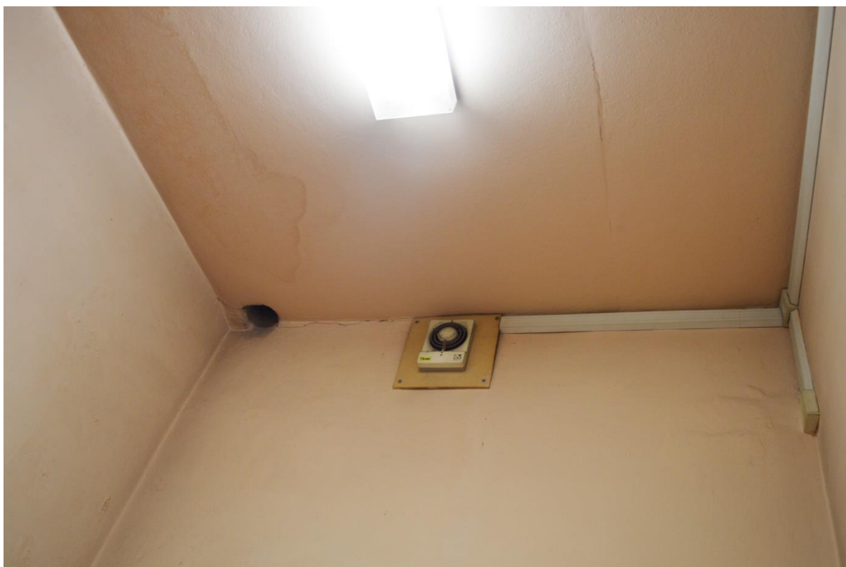
F67. Stato di fatto, locale P2.04 – Soffitto – Prova per verifica solai esistenti
