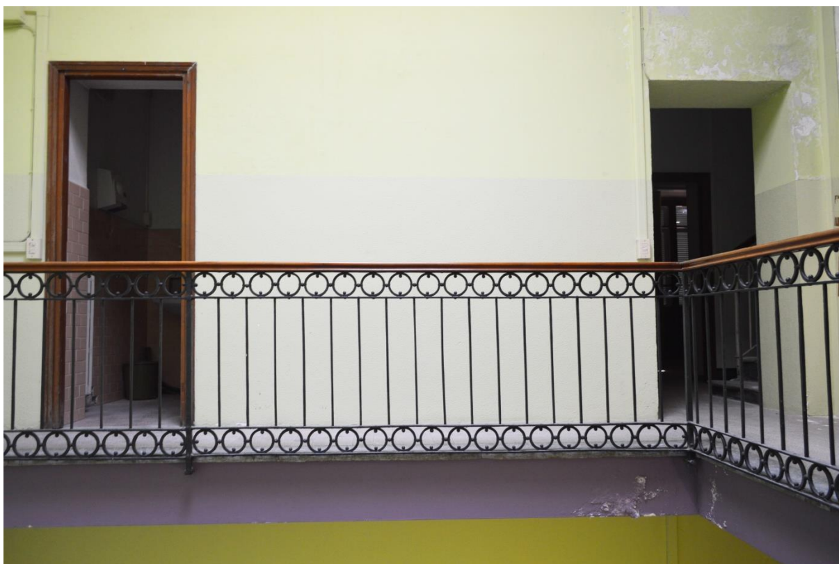
F77. Stato di fatto, locale P2.08 – ballatoio di collegamento al bagno di servizio
