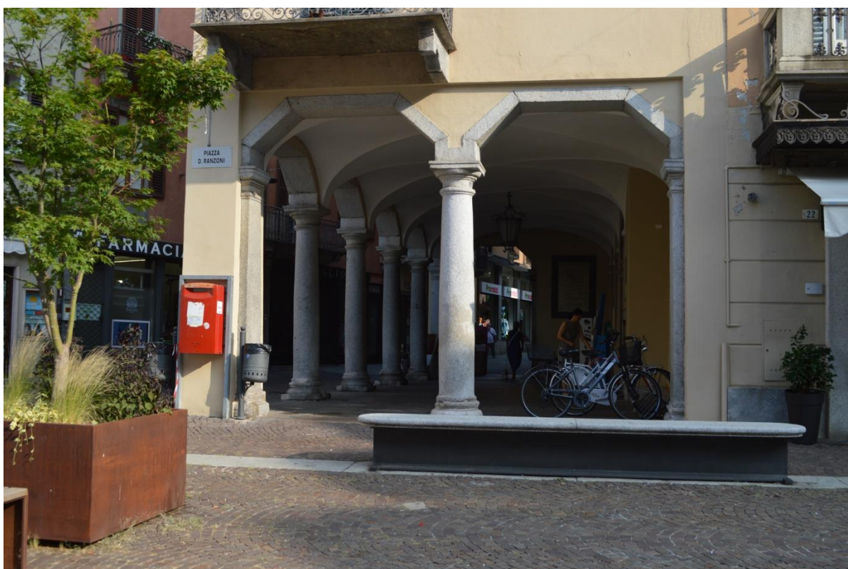
F09. Piazza D. Ranzoni, portico al piano terra fronte sud
