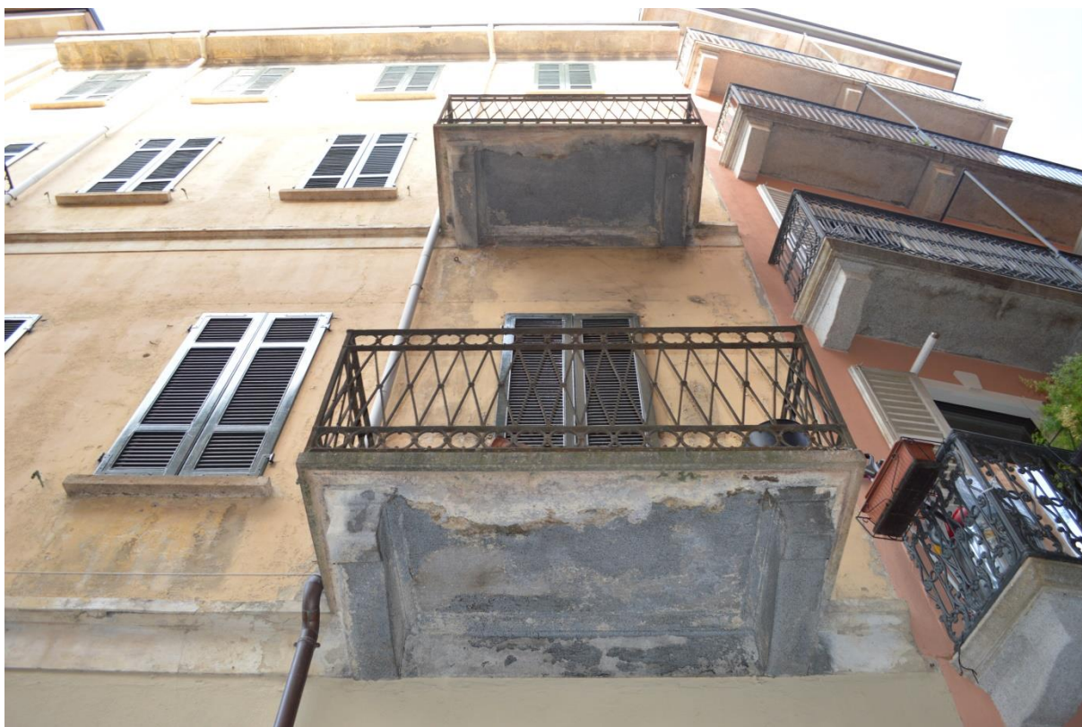
F03. Via San Vittore, piano primo: particolare dei balconi in beola grigia e mensole in granito con ringhiere in ferro
