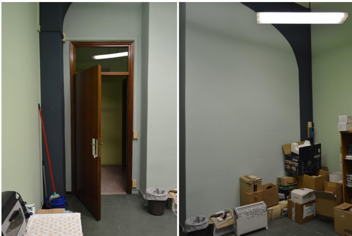
F42. Stato di fatto, locale P1.03 – Serramenti interni e colorazione pareti
