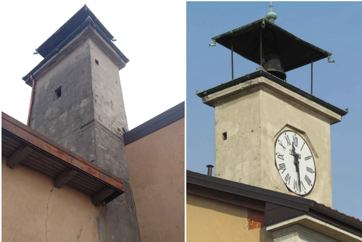
F30. Particolari della torre e dell'orologio
