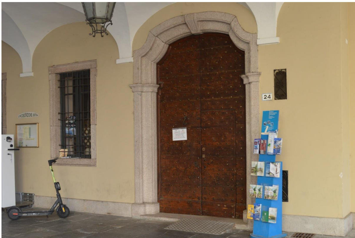
F19. Fronte ovest, piano terra: ingresso con portale in granito rosa e portone in legno naturale con borchie in ottone – finestra al piano terra con contorni in granito rosa – griglie di areazione in ferro battuto
