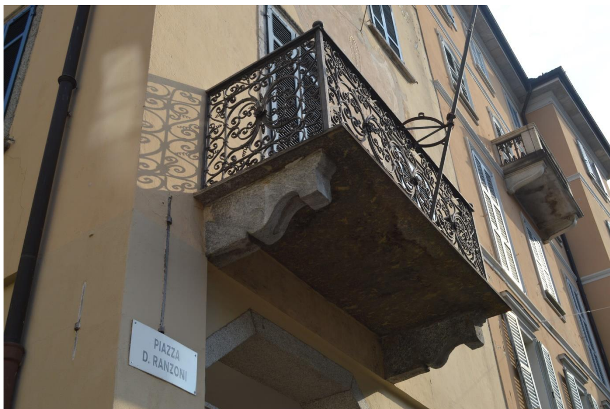
F10. Fronte sud, piano primo: particolare del balcone in beola grigia e mensole in granito con ringhiere in ferro
