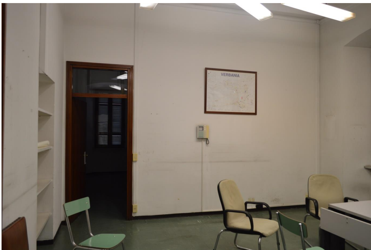
F49. Stato di fatto, locale P1.07
