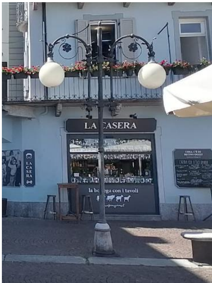
Figura: palo di arredo urbano a doppio sbraccio con apparecchio illuminante sferico
