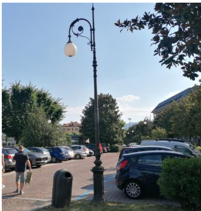
Figura: punto luce di illuminazione pubblica a sbraccio singolo con apparecchio a sfera
