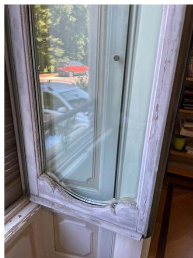
Fig.39 – Battuta orizzontale a spigolo vivo
