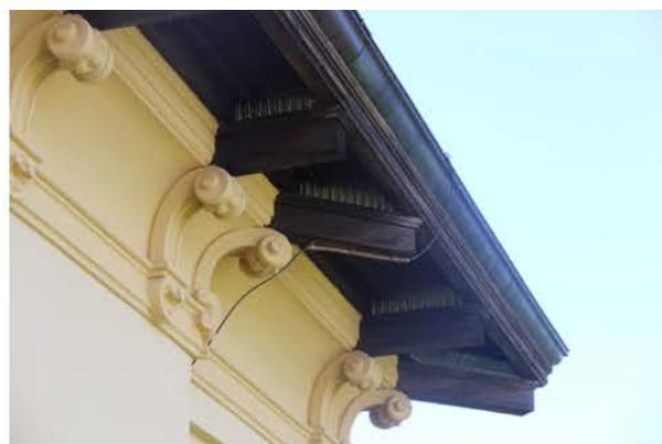
Fig.13 - Cornicione, mensole e sottogronda.
