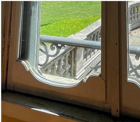
Fig.28 – Spessore ligneo con vetrocamera
