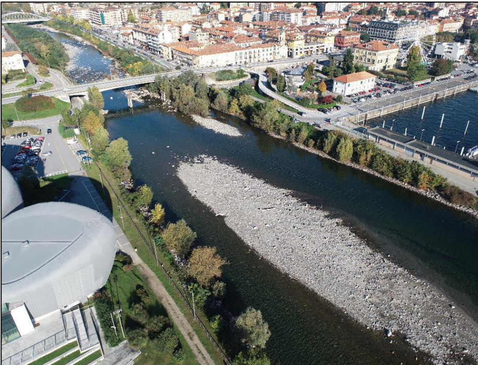
Figura 15. Vista dell'alveo del torrente San Bernardino.
