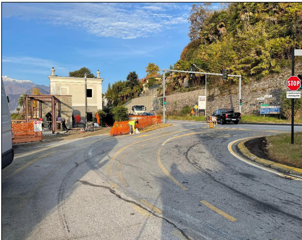
Figura 1. Intersezione SS34 con via Paolo Troubetzkoy.
