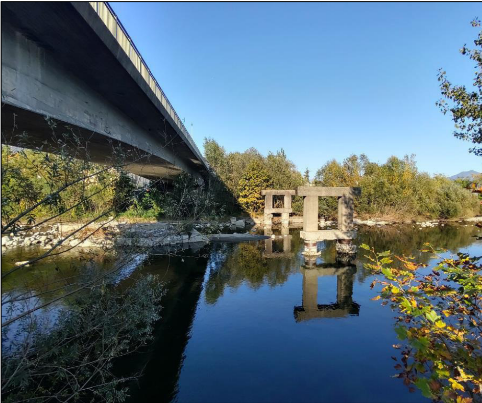
Figura 14. Struttura del ponte.
