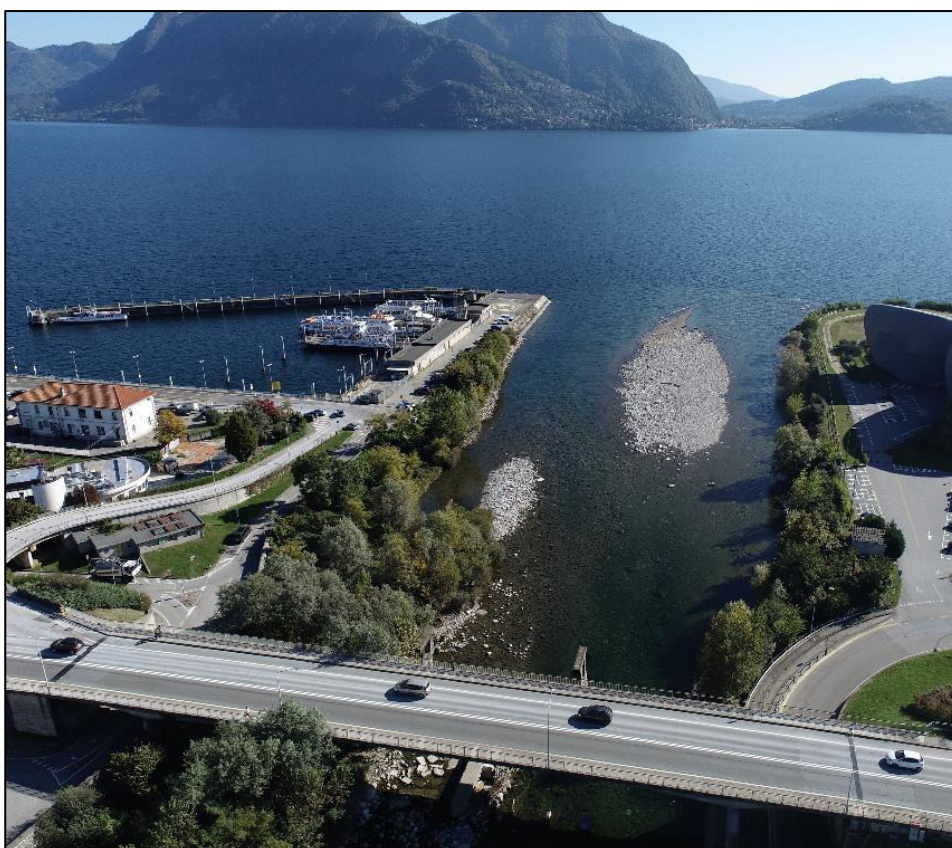
Figura 13. Vista panoramica del ponte sul torrente San Bernardino.
