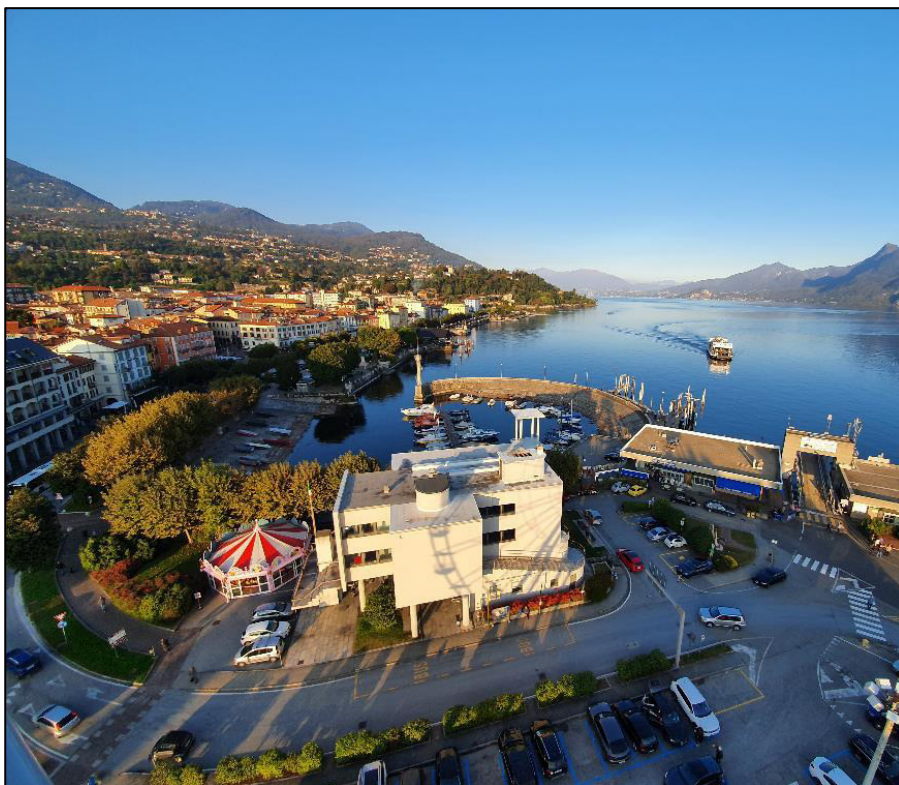
Figura 20. Vista di Palazzo Flaim.
