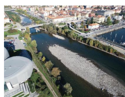
Vista dell'alveo del torrente San Bernardino
