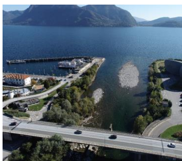
Vista panoramica del ponte sul torrente San Bernardino
