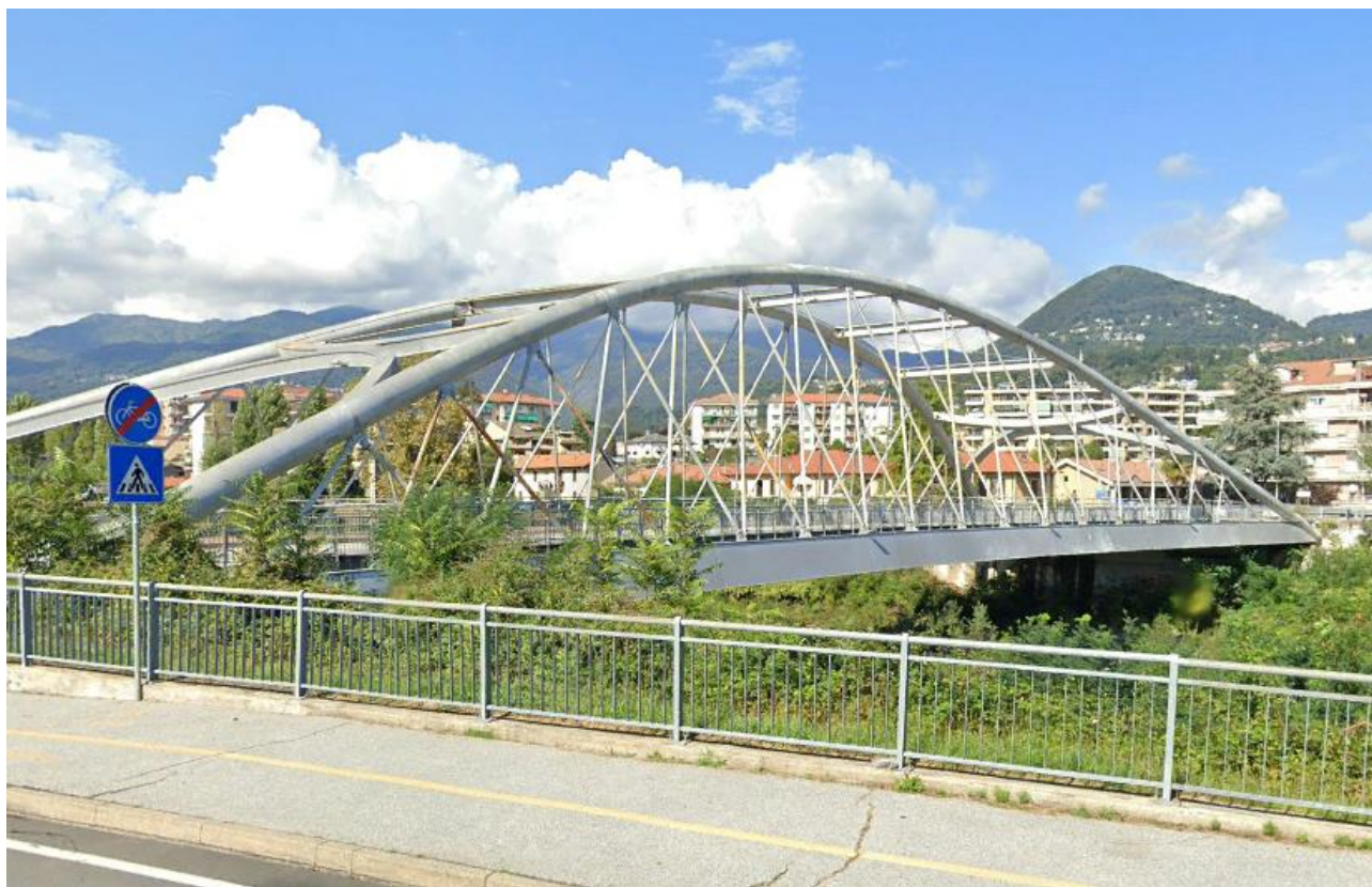
Il cosiddetto "Terzo ponte", posto immediatamente a monte del ponte Anas.
