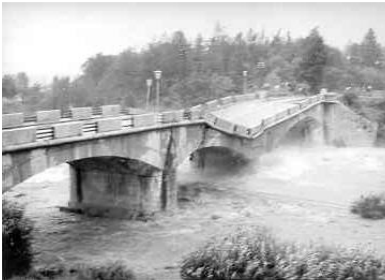
Il crollo del ponte sulla strada nazionale avvenuto nel 1965.
