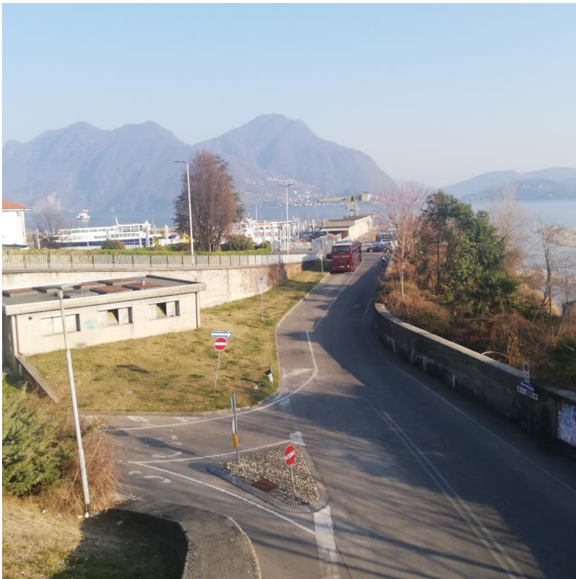
Sponda sinistra con la complessa viabilità di accesso ai traghetti.
