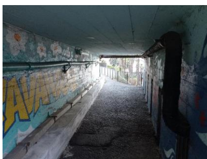
Sottopasso pedonale di Corso Nazioni Unite
