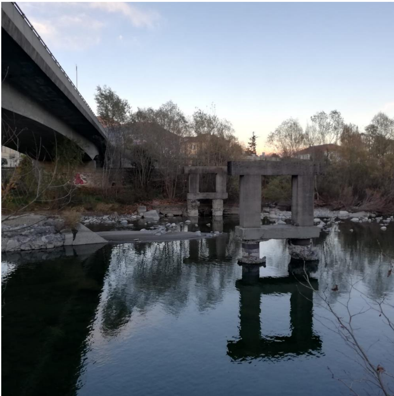
I resti delle fondazioni del ponte ferroviario a valle dell'attuale ponte Anas.
