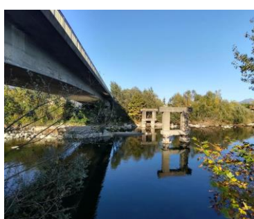
Struttura del ponte
