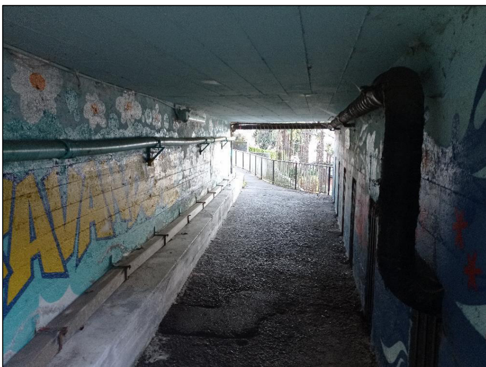
Figura 50. Foto_31_ Sottopasso esistente.
