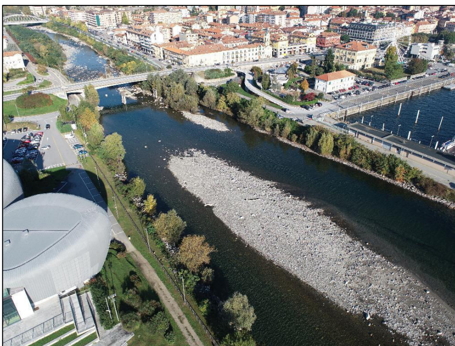
Figura 34. Foto_15_Vista dell'alveo del torrente San Bernardino.
