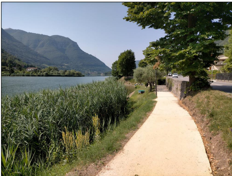
Figura 52. Esempio di tracciato realizzato con Nature Stabil Road.
