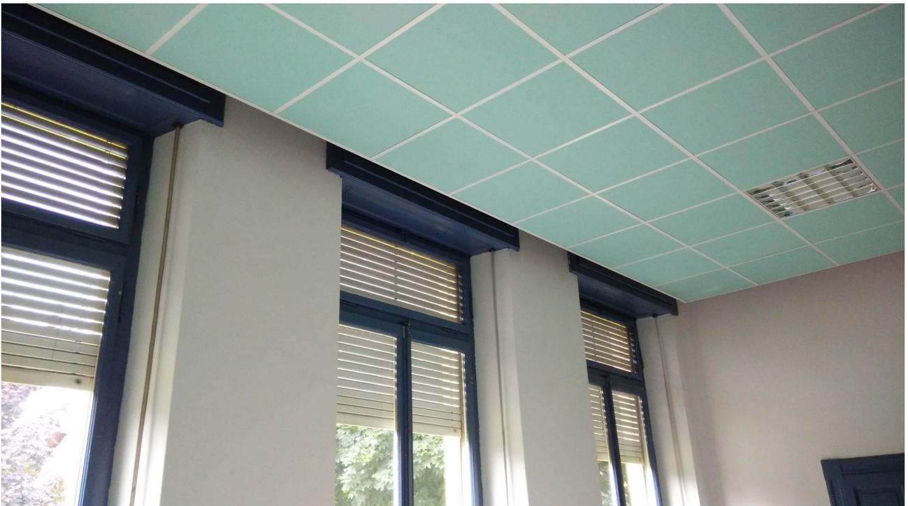
**FIG. 17: IMMAGINI DELLE TAPPARELLE AVVOLGIBILI DA SOSTITUIRE**
