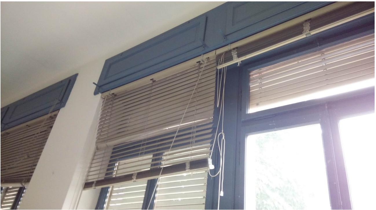
**FIG. 16: IMMAGINI DELLE TAPPARELLE AVVOLGIBILI DA SOSTITUIRE**
