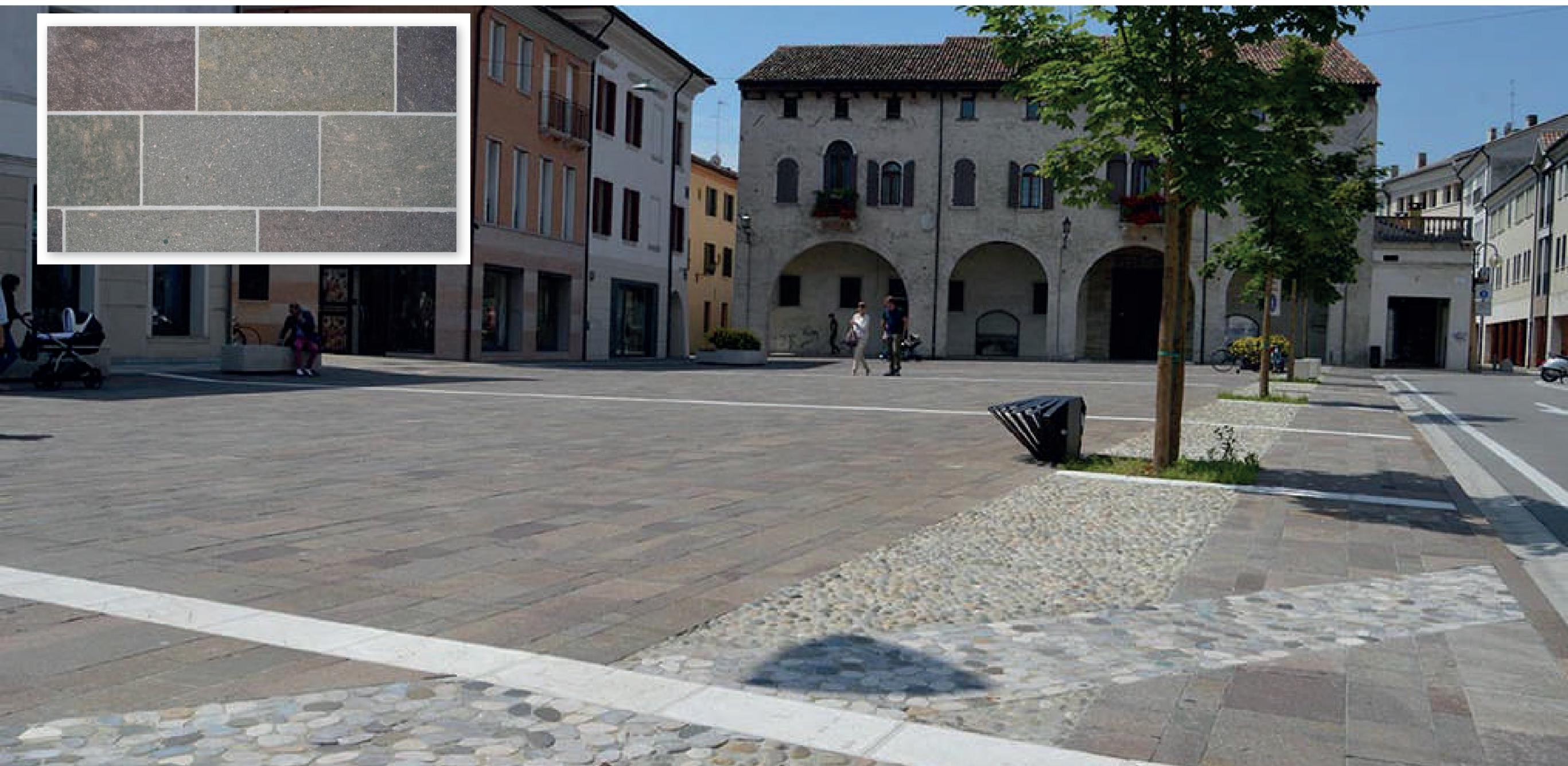
Pavimentazione in piastrelle di porfido posate a correre, e fasce intermedie / laterali in lastre di granito Montorfano
