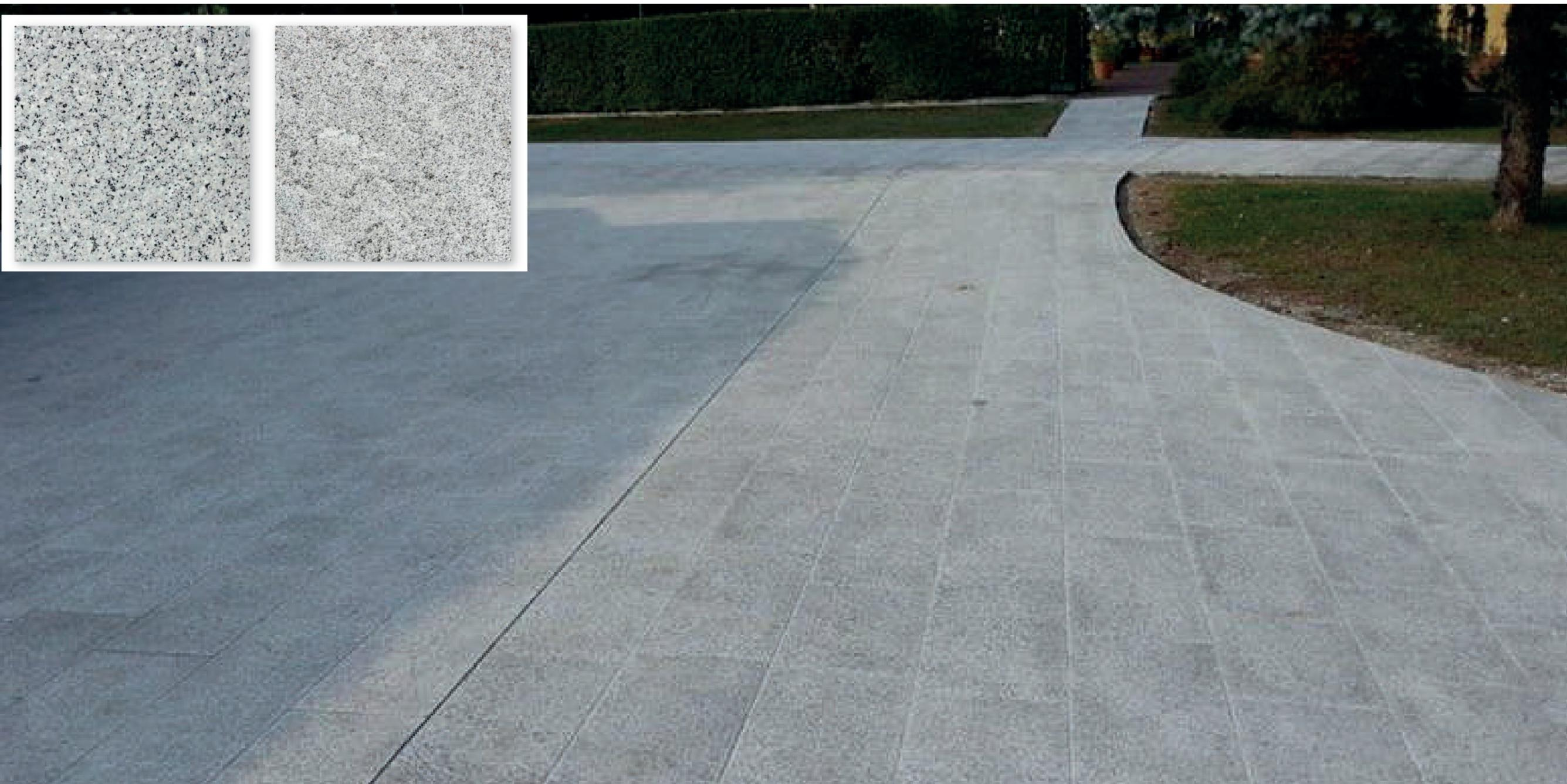
Pavimentazione in lastre di serizzo Antigorio posate a correre, e fasce intermedie / laterali in lastre di granito Montorfano
