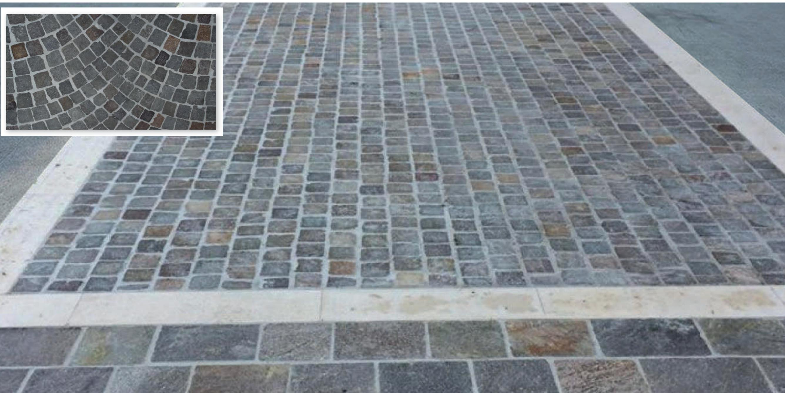
Pavimentazione in cubetti di porfido e fasce laterali in lastre di granito Montorfano
