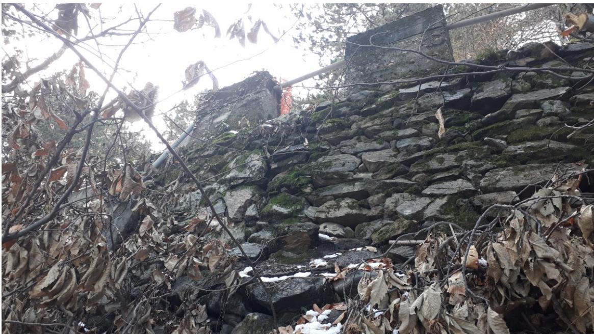
Foto 6 – dettaglio stato conservativo muro di contenimento tornante in sasso a secco
