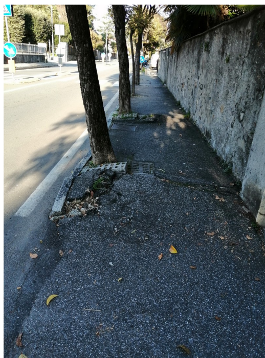
Deformazioni pavimentazione
