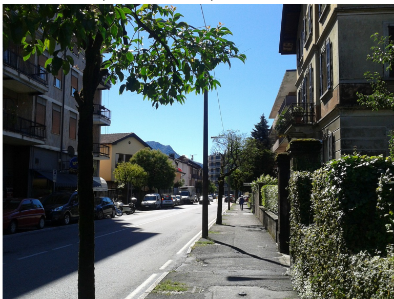
Marciapiede lato ovest
