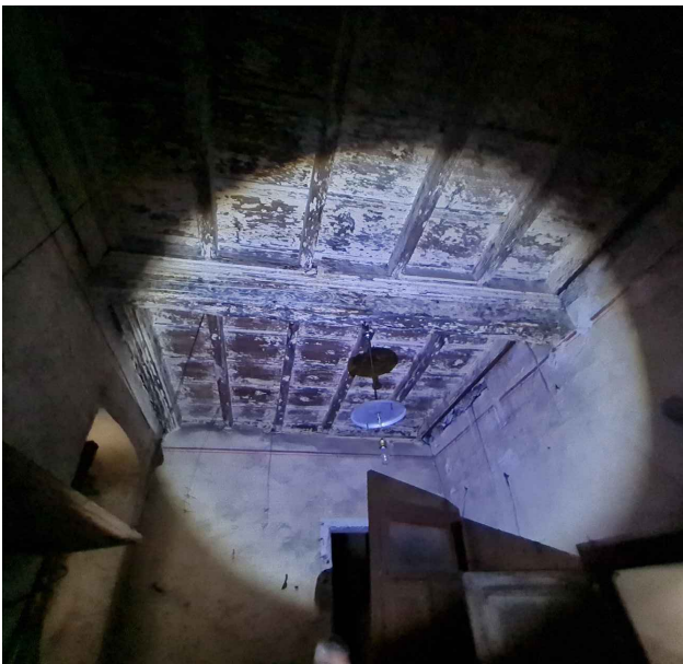
Ambiente A24 PARTICOLARE SOFFITTO
