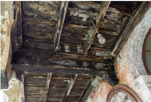
Ambiente A12 (confinante con A16) PARTICOLARE SOFFITTO
