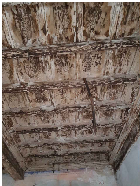
Ambiente A19 PARTICOLARE SOFFITTO
