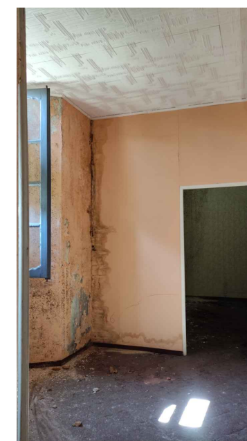
Ambiente C06 SOFFITTO LIGNEO NASCOSTO DA CONTROSOFFITTO
