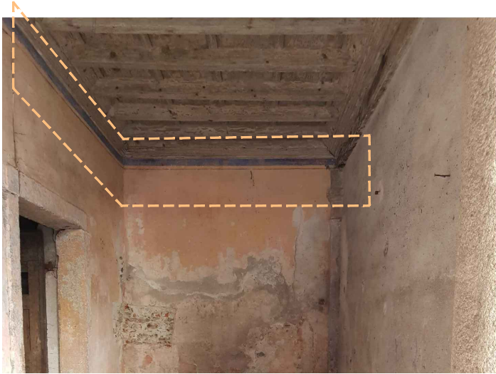
Ambiente A18 PARTICOLARI DECORI SOTTO CORNICE IN LEGNO
