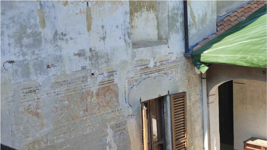
Ambiente A15 CORTILE PARTICOLARE FACCIATA
