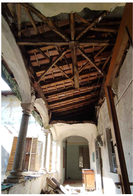
Ambiente B10 SOLAIO PARZIALMENTE CROLLATO
