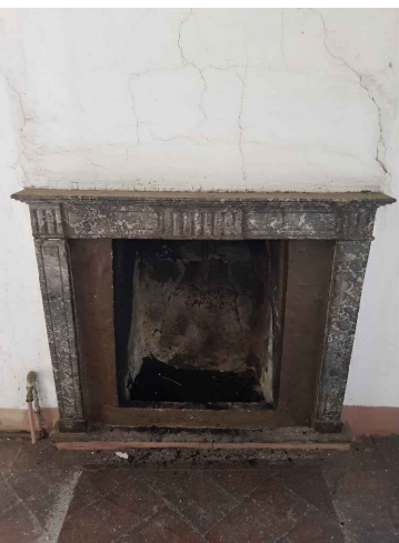
Ambiente B23 PARTICOLARE CAMINO
