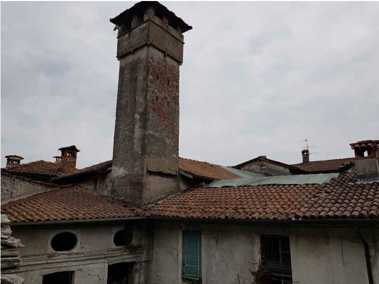
Coperture VISTA VERSO NORD
