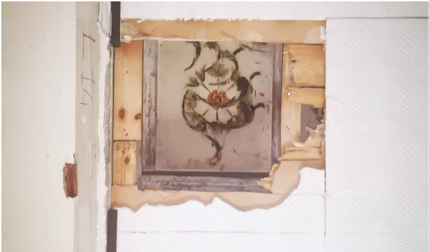
Ambiente A03. PARTICOLARE SOFFITTO NASCOSTO DA CONTROSOFFITTO
