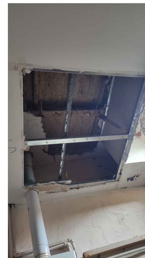
Ambiente C10 INCANNUCCIATO NASCOSTO DA CONTROSOFFITTO
