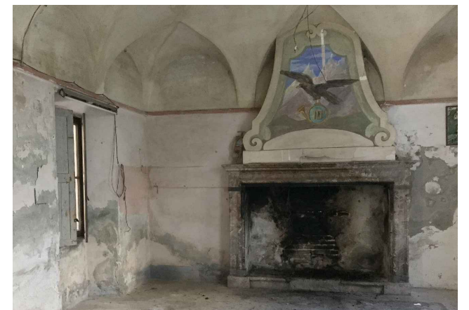
Ambiente A16. PARTICOLARE CAMINO
