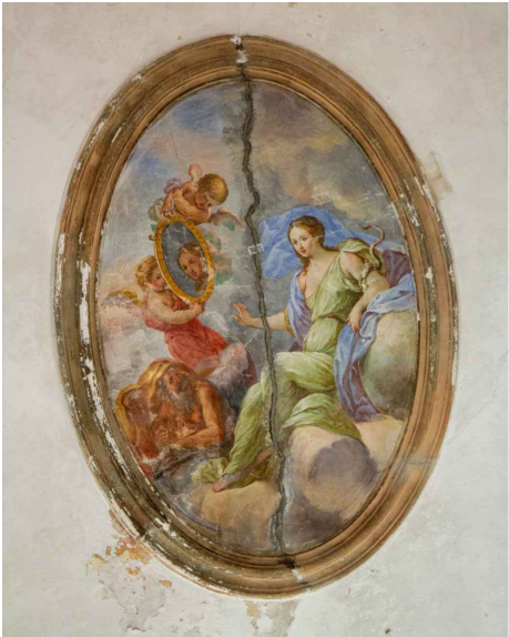
Ambiente BS01 (scala) PARTICOLARE DEL SOFFITTO
