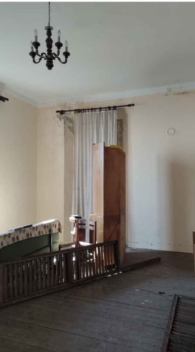
Ambiente C9 PAVIMENTO LIGNEO
