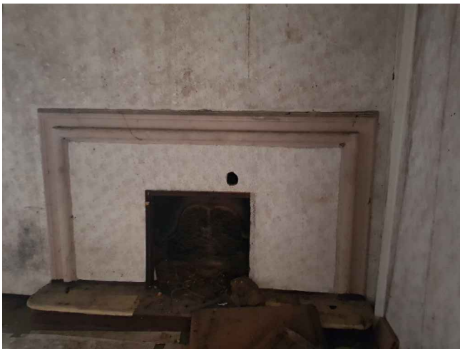
Ambiente B16. PARTICOLARE CAMINO
