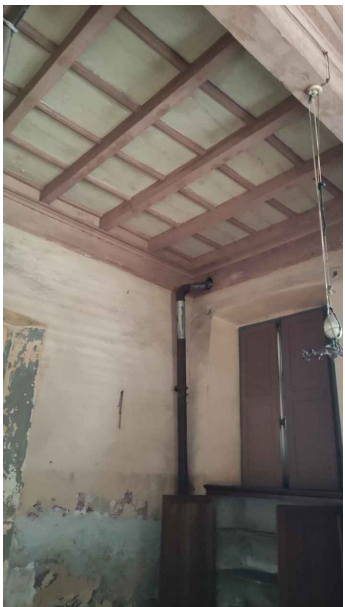
Ambiente A22 PARTICOLARE SOFFITTO
