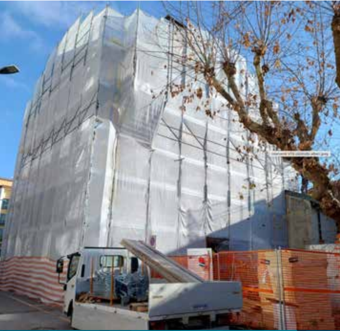
Intervento riqualificazione case via Restellini - Intra
