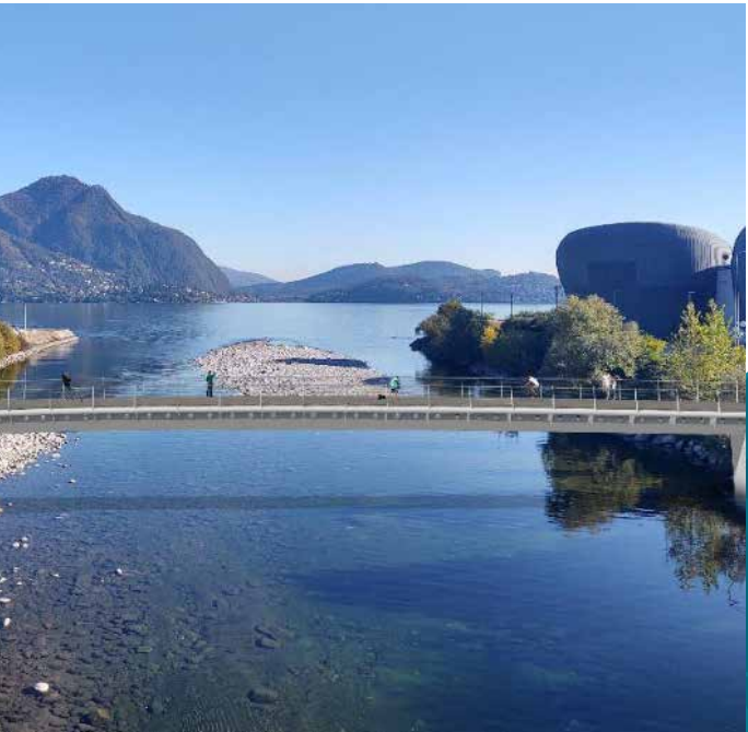
Passerella pedonale sul torrente San Bernardino
