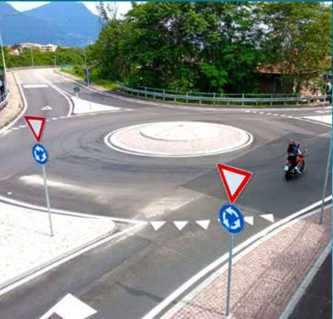
Rotonda e nuovo marciapiede zona Plusc
